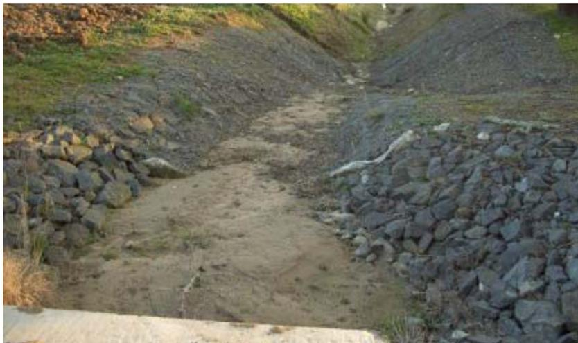
Fotografia 2.1.4 – Protecção da saída de uma passagem hidráulica
