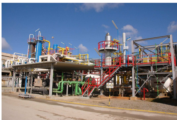
Figura 6.10 – Exemplo de uma estrutura do complexo industrial CUF-QI.
