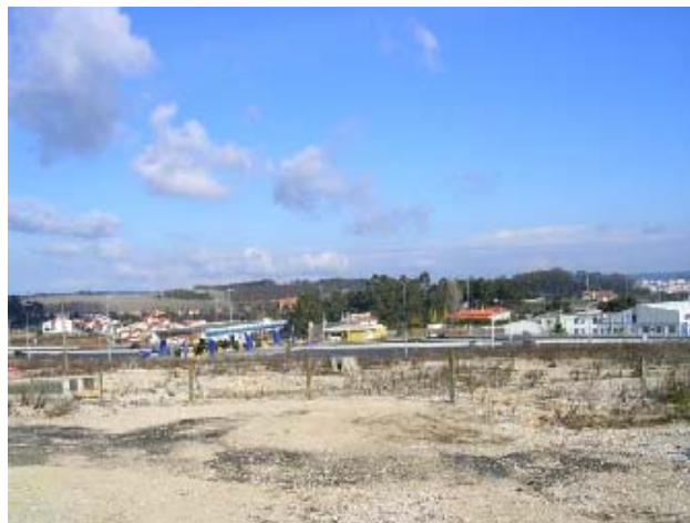
Fotografia 10 - Depósitos de aterro. Ligação da A8 ao IC2. Em 2º plano a praça de portagem
