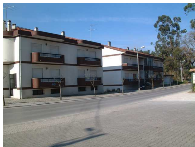
Fotografia 6 – Edifício multifamiliar de dois pisos (o da direita) na intersecção do ramo norte do túnel do Telheiro
