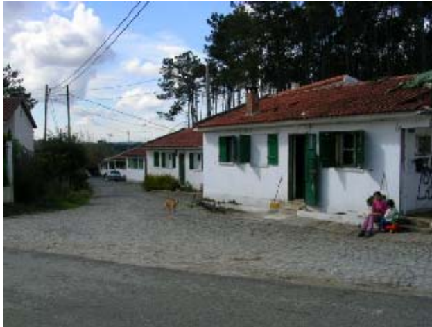
Fotografia 7 - Habitação do conjunto em banda já demolida, entretanto, e cuja família já foi realojada. A necessidade de demolição da habitação seguinte será avaliada em Fase de Projecto de Execução
