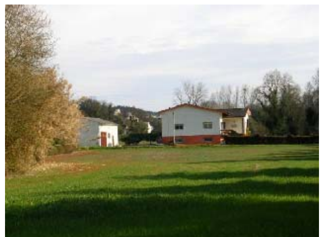
Fotografia 12 - Conjunto edificado junto à EM 544 no vale do rio Lis
