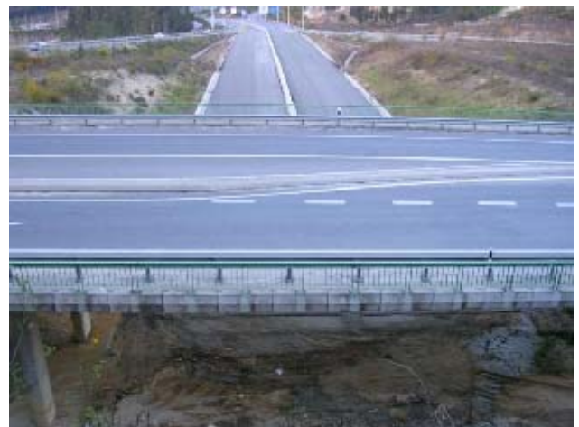
Fotografia 16 - Passagem superior na EN 113 sobre o IC36, já construída. Em 2º plano a ligação ao nó da COL
