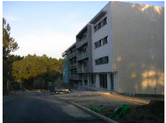
Fotografia 14 - Edificações em construção na urbanização a sul de Pousos
