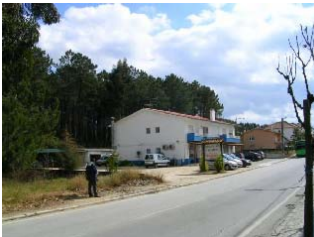
Fotografia 9 - Edifício de habitação e restaurante entre os dois ramos do túnel de Telheiro
