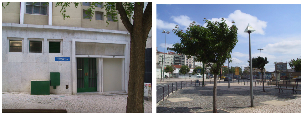
Figura 25 - Vista sobre a entrada do edifício da PT (à esquerda) e sobre a zona da entrada do Parque de Estacionamento de Campolide (à direita)
