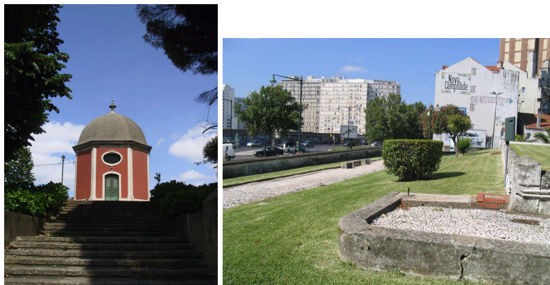
Figura 24 – Vista sobre o Reservatório do Pombal – instalações da EPAL (visível o limite de um dos reservatórios da EPAL – à direita)
