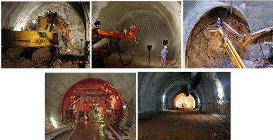
Figura 2 – Escavação de Túnel em NATM – decurso das actividades no troço Posto de Ventilação 2 –Estação São Sebastião II
