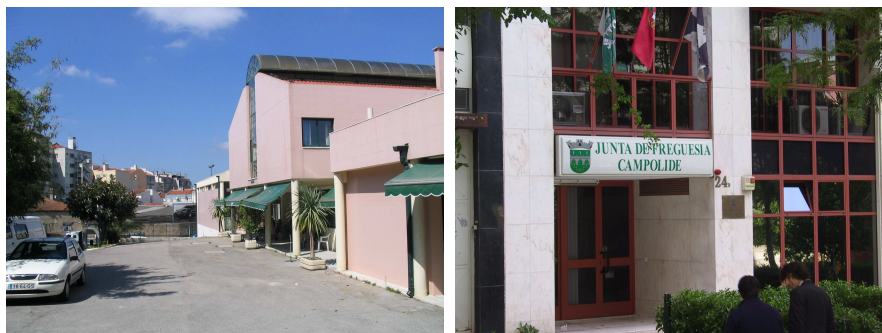
Figura 22 - Vista sobre o Centro de Apoio a Idosos da EPAL (à esquerda) e sobre o edifício da sede da Junta de Freguesia de Campolide, a partir da Rua de Campolide, nas imediações do previsto Posto de Ventilação 3 (à direita)
