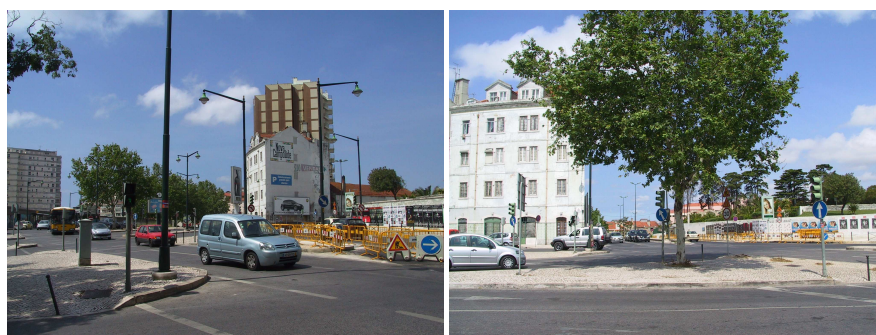
Figura 26 - Vista sobre a zona onde será implantado o poço de ataque (construção) e futura Estação Campolide (perspectivas a partir da Rua Marquês da Fronteira (1ª foto) e da Rua da Artilharia 1 (2ª foto))
