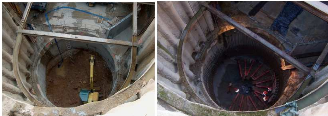
Figura 4 – Escavação a “céu aberto” – início e conclusão da escavação do Posto de Ventilação 1
