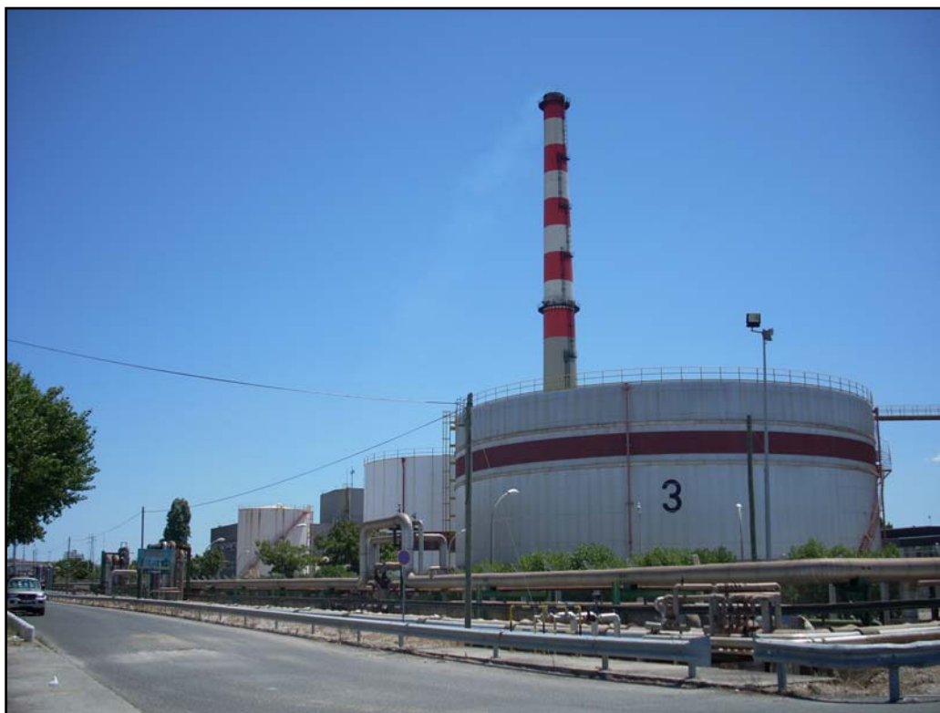
Foto II.1 – Central Termoeléctrica do Barreiro (a desactivar)
