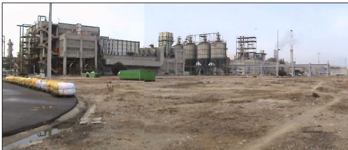
Foto IV.17 – Aproximação às instalações existentes junto à localização da nova Central
