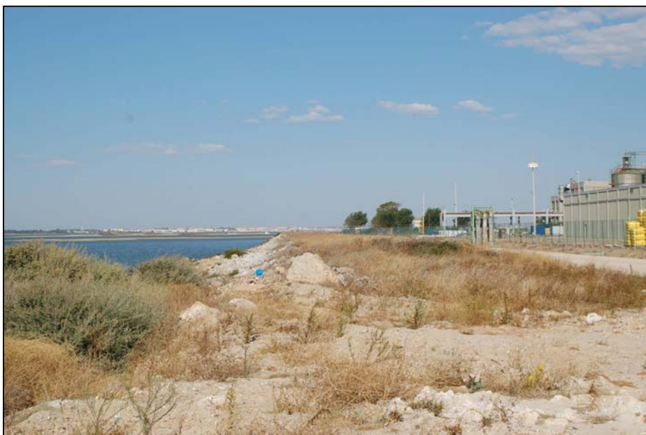
Foto IV.13 – Fronteira entre a Unidade Industrial onde será implantada a Central e o Estuário
