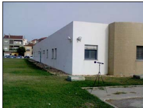
Foto IV.8 – Envoltente do local de medição PM14 – Centro de Saúde do Lavradio
