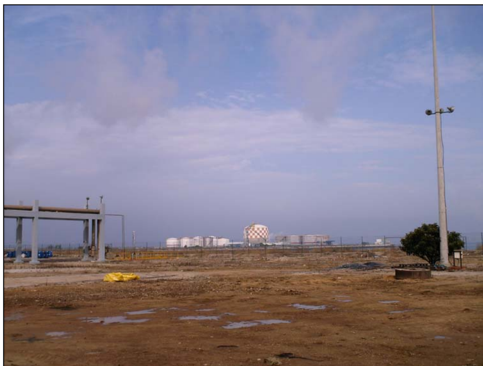
Foto IV.25 – Área de Implantação do Projecto, de Sul para Norte
