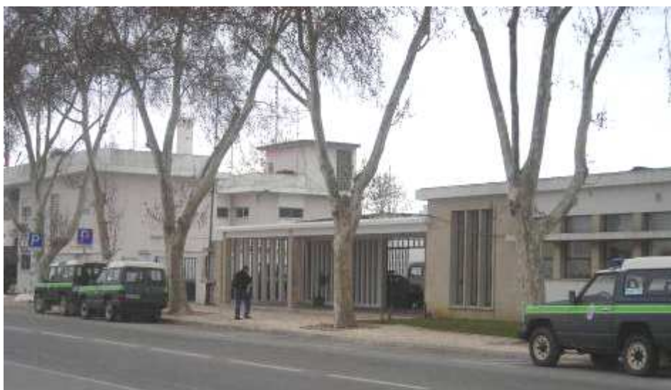
Fotografia 3.1.11 – Edifícios da Capitania do Porto e da GNR no lado Oeste da embocadura do Porto
