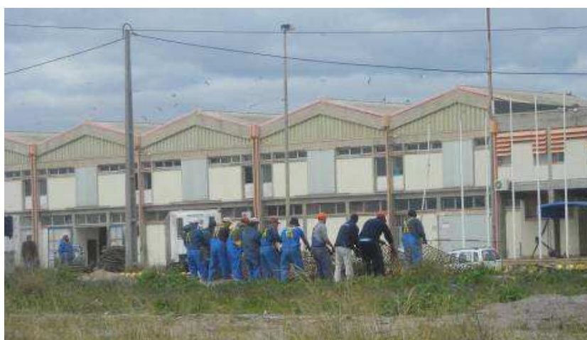
Fotografia 3.1.3 – Actividades em curso junto ao lado Norte da área de intervenção do projecto
