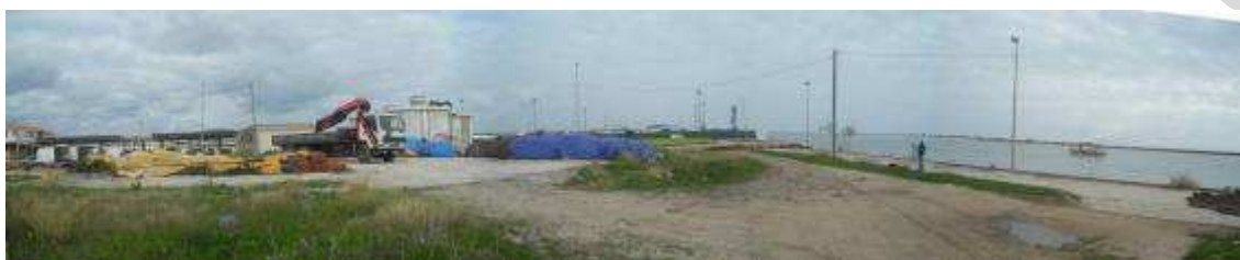
Fotografia 3.1.1 – Enquadramento geral da área de intervenção do projecto (lado Nascente)
