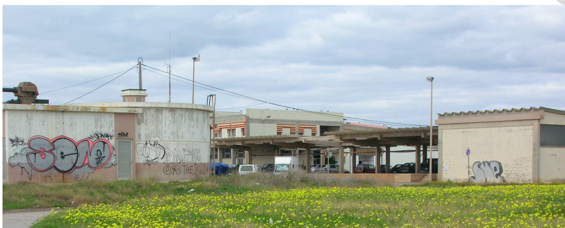
Fotografia 3.1.6 – Infra-estruturas terrestres do Porto de Pesca de Olhão (à esquerda – estação de dessalinização; ao fundo – zona industrial portuária)
