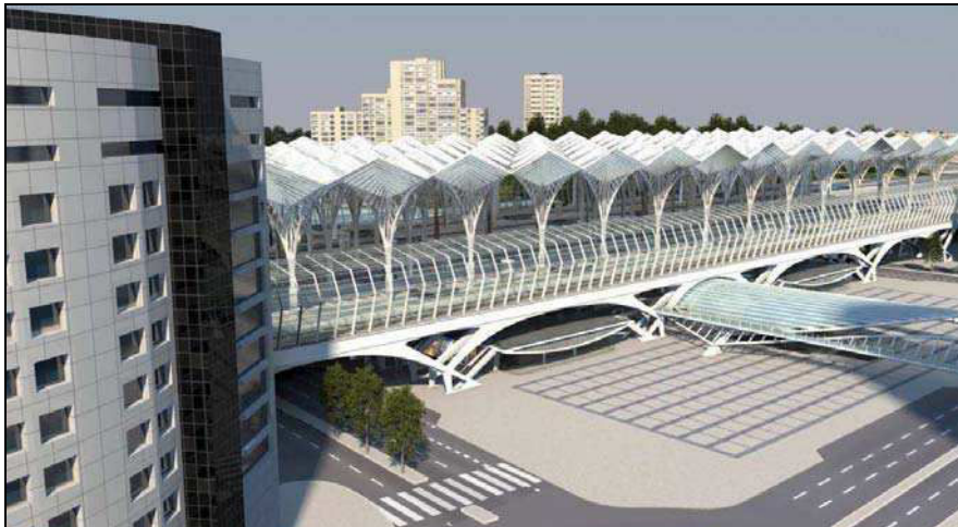
Figura 4.1 - Vista do lado nascente da Estação do Oriente, onde se pode ver a proposta dos novos pára-ventos
