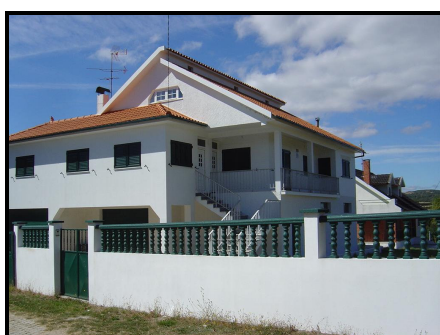
Foto 5 – Quintela - Aglomerado habitacional ≈ 1220m a norte/nascente da futura Subestação Ponto de Medição M5
