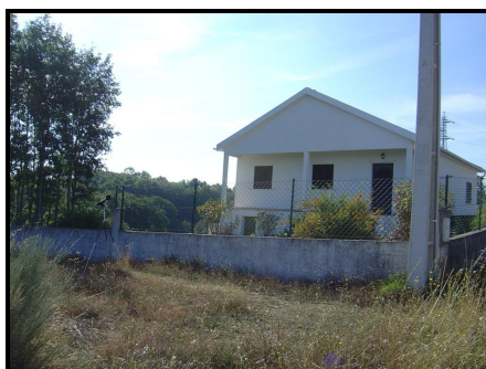
Foto 1 – Ferrugende - Habitação isolada ≈ 845m a sul/nascente dos limites da futura Subestação Ponto de Medição M1
