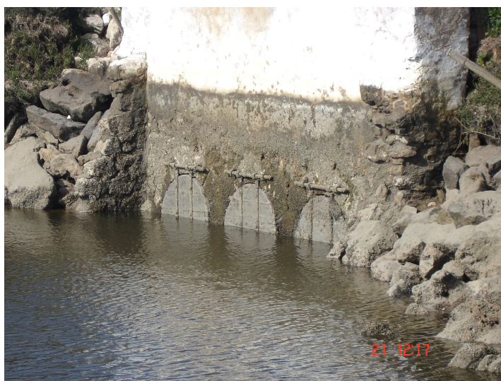
Figura 3 – Aspecto das comportas n.º 1 fechadas em situação de enchente
