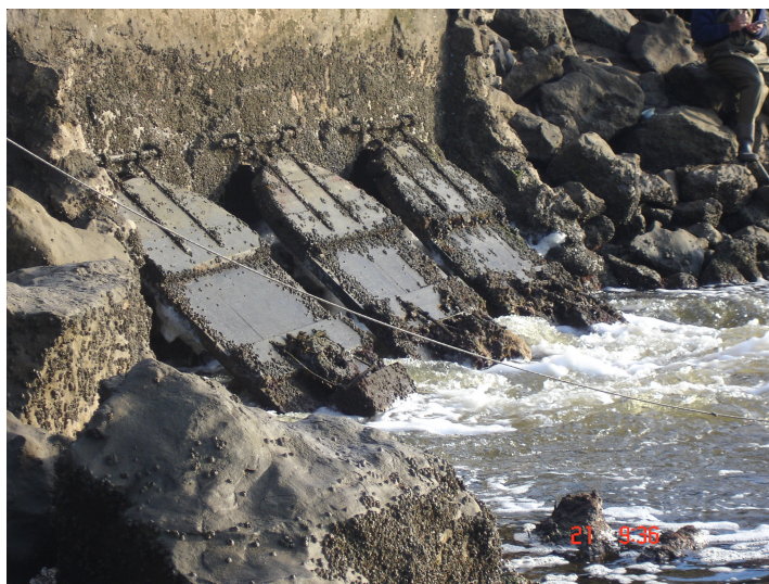
Figura 2 – Aspecto das comportas abertas em situação de vazante. Passagem hidráulica identificada como n.º 1 na Figura anterior
