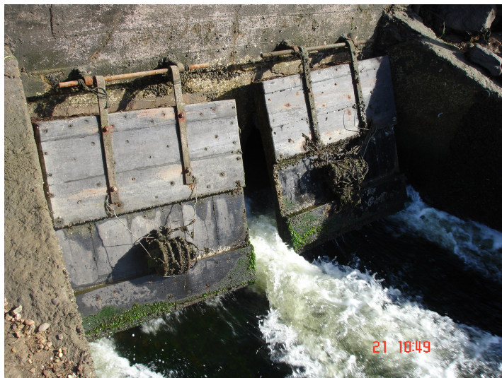
Figura 4 – Aspecto das comportas n.º 3 abertas em situação de vazante
