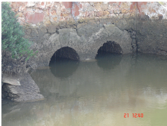
Figura 5 – Aspecto do lado de montante da comporta n.º 3
