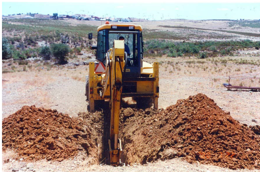
Figura 3.1 - Aspecto da execução de um poço de prospecção mecânica
