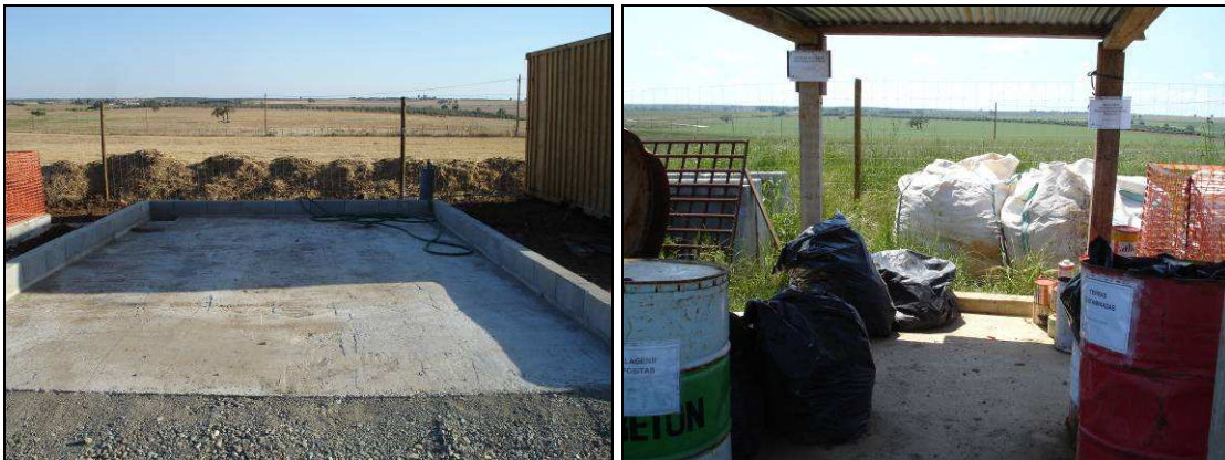
Figuras 11 e 12 – Zona de Lavagem de veículos e equipamentos e Parque de Resíduos Perigosos.
