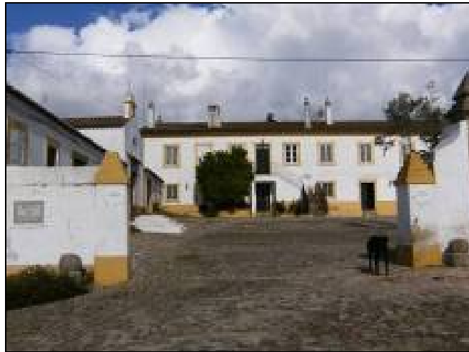
Casa de Habitação do Monte da Crucieira
