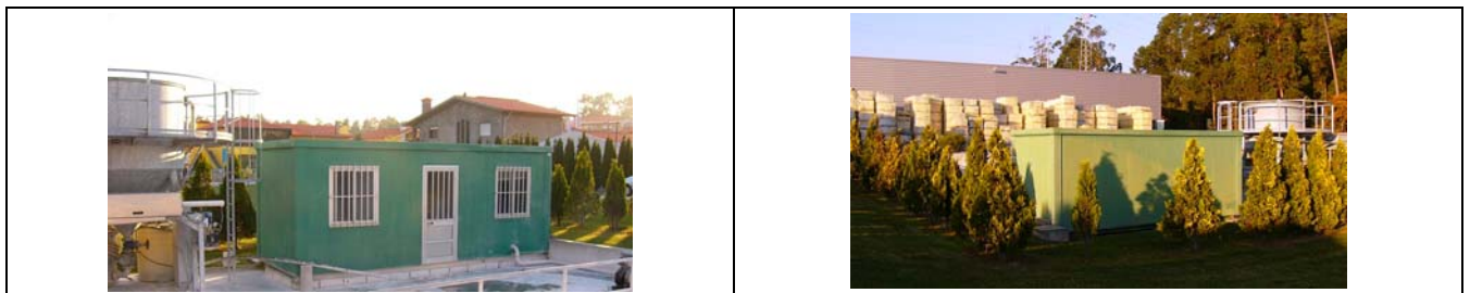
Figura 11: Isolamento acústico das bombas de funcionamento do tanque de águas residuais da CINCA UP Fiães III
