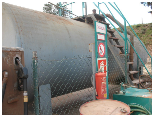
Figura 3.2.12 – Depósito de Gasóleo existente na pedreira.
