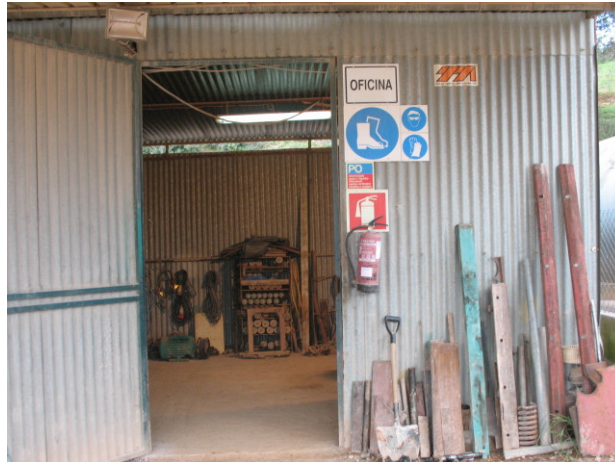
Figura 3.2.4 – Oficina existente na pedreira.
