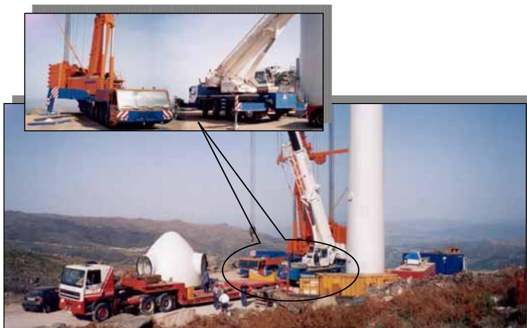
Figura 8 – Ocupação e dimensão necessária de uma plataforma para a montagem de aerogeradores de 2000 kW.
