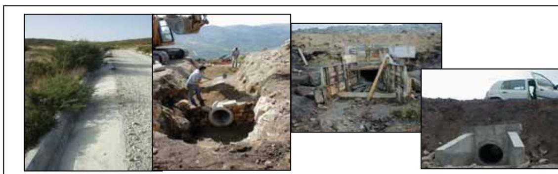
Figura 6 – Valeta e construção de uma passagem hidráulica.
