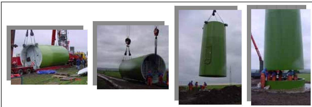
Figura 9 – Montagem da torre de um aerogerador.
