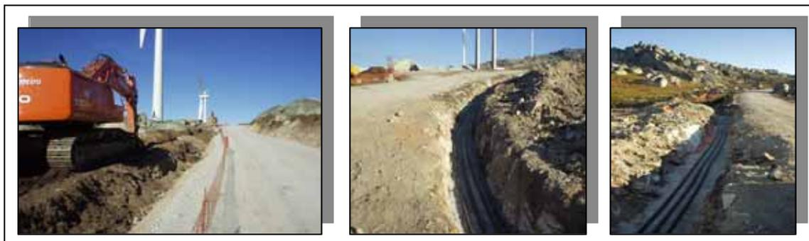
Figura 11 – Vala para instalação dos cabos eléctricos subterrâneos.
