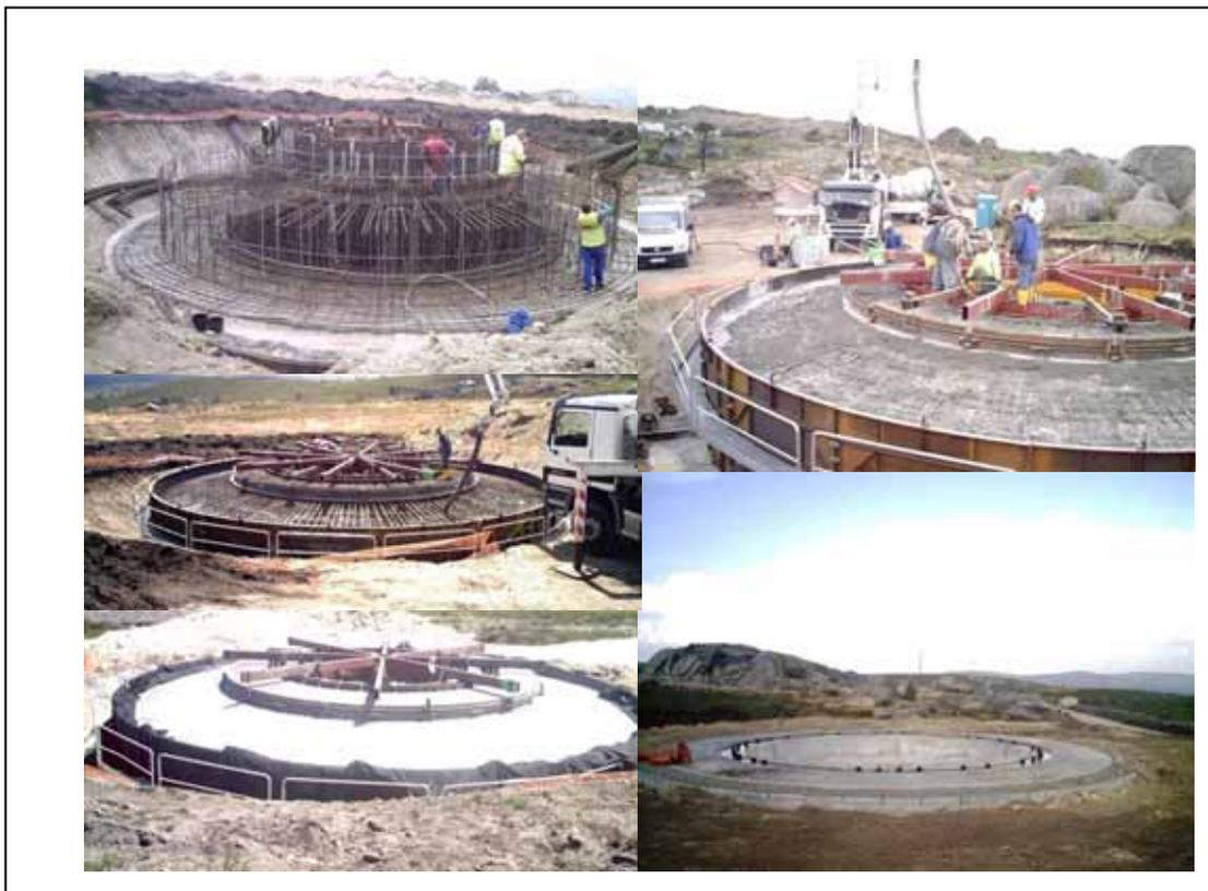
Figura 7 – Execução da fundação da torre de um aerogerador.
