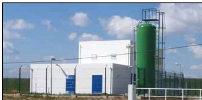
Figura 4-7 – Estação elevatória do Troço de Ligação Loureiro-Monte Novo.
