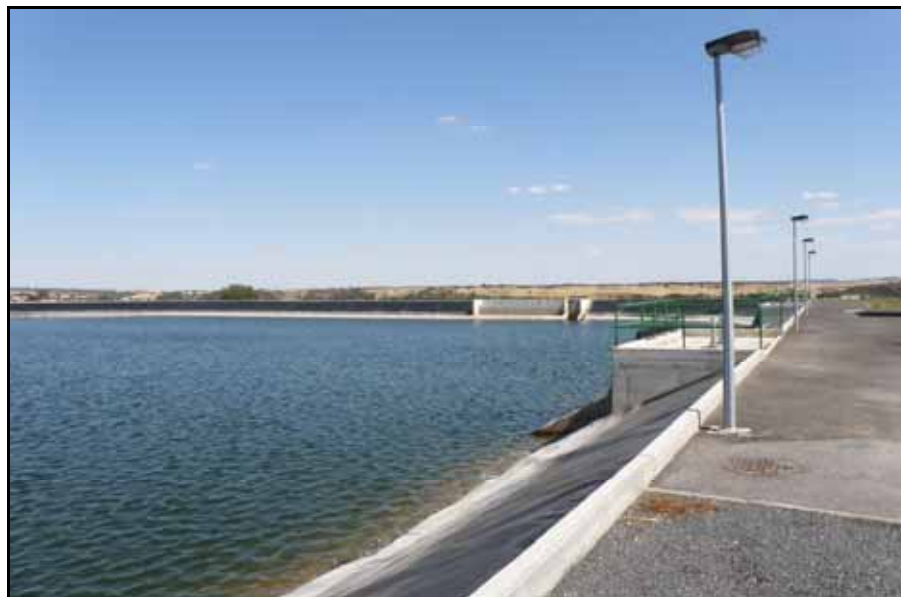
Figura 4-5 – Reservatório do Aproveitamento Hidroagrícola do Roxo.
