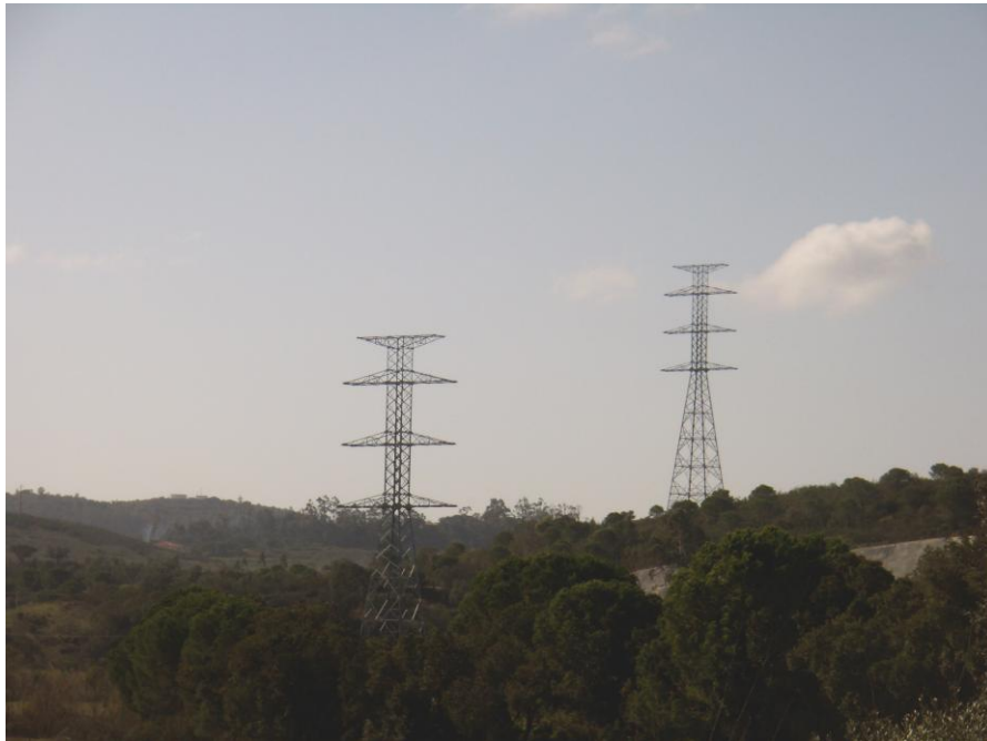
Figura 4 – Apoios a desmontar, junto à parte final do traçado
