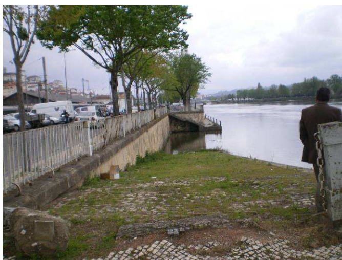
Figura 2 - Zona de muros de alvenaria de pedra
