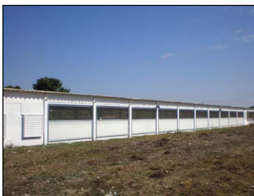
Figura 3.2 – Pavilhão 2 do sector VII (foto 2)
