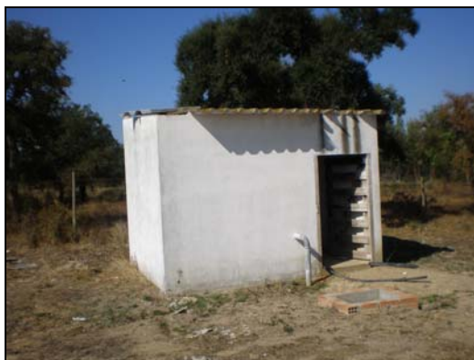
Figura 3.9 – Edifício onde está localizado o furo e a respectiva bomba de água
