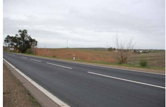
Fotografia 2 - Local de atravessamento do actual IP8 pelas Solução 1
