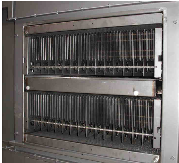
Figura 5 – Equipamento de Extracção e Filtragem KMA Ultravent – Filtro de Entrada
