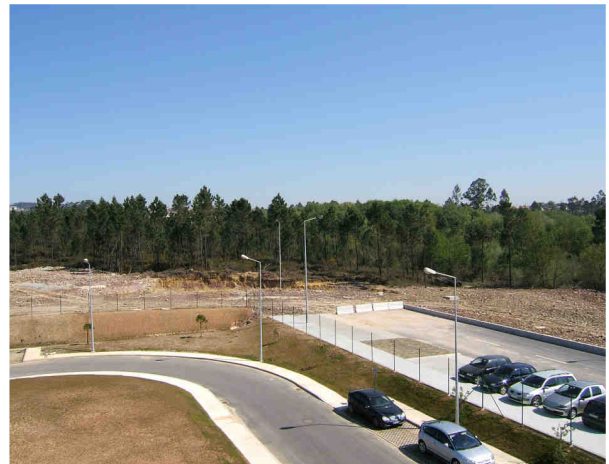
Figura 48 - Vista Nascente, que mostra via ainda em execução pelos serviços camarários
