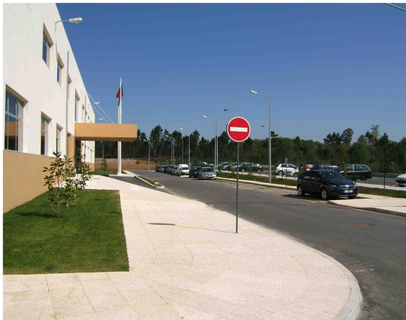
Figura 47 - Entrada Principal para a Unidade Industrial
