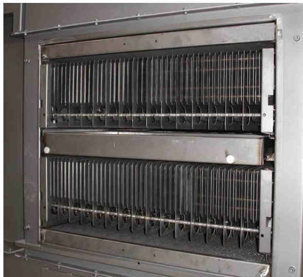
Figura 20 - Electro filtro com duas secções de filtragem
