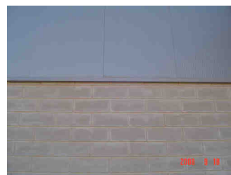
Figura 3 – Aplicação mista: alvenaria constituída por blocos de betão branco, e parte superior composta por painéis sanduíche.
