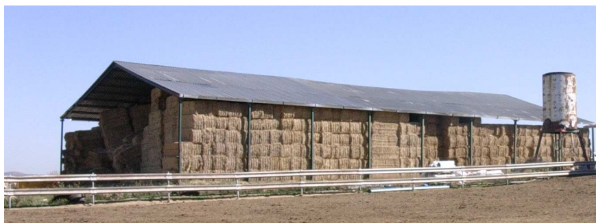
Figura 3 – Armazém de feno
