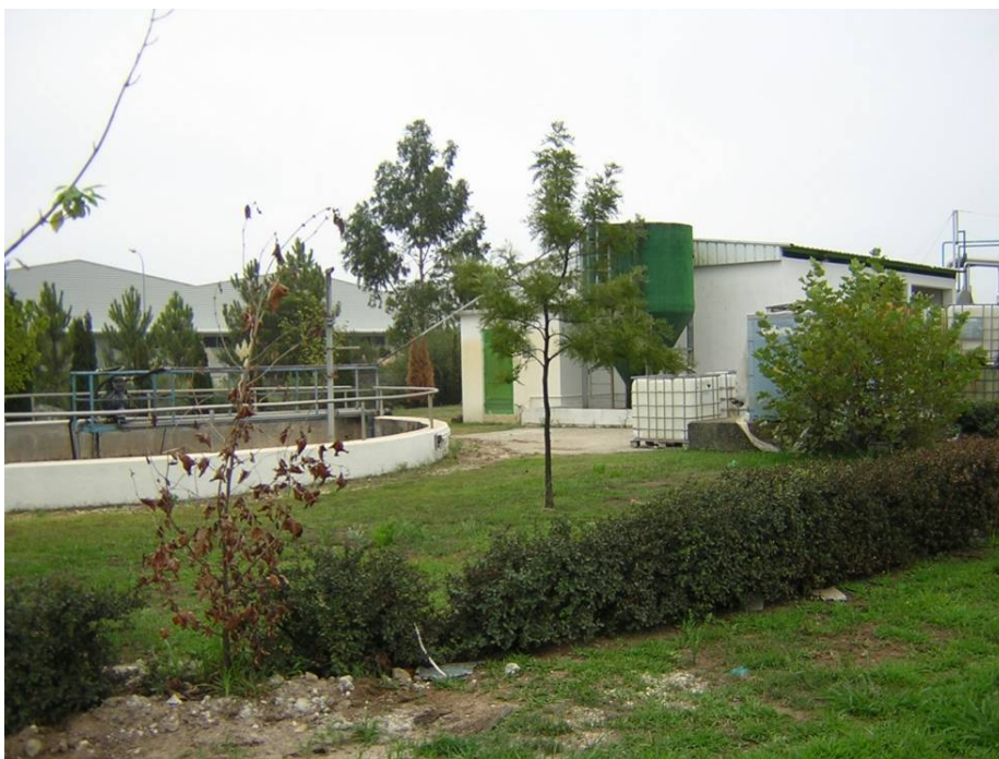
Figura 1 – Aspecto geral na zona da ETAR e zona ajardinada adjacente.
