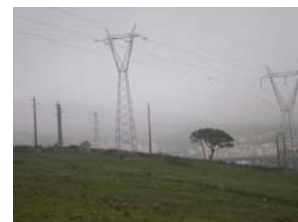
Linhas eléctricas na área de projecto
