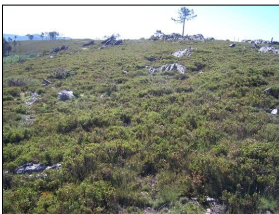
Figura 25 - Vista geral da implantação do aerogerador 17 (vista Oeste-Este)
