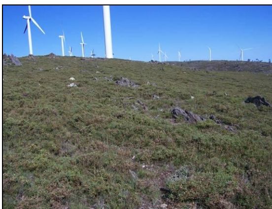
Figura 24 - Vista geral da implantação do aerogerador 17 (vista Este-Oeste)
