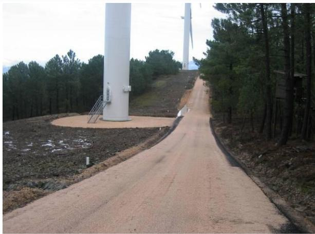
Foto 9 – Plataforma de montagem de aerogerador após os trabalhos de modelação e recuperação
