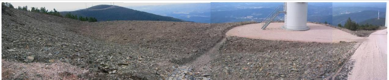
Foto 11 – Aspecto final de um plataforma de montagem (depois dos trabalhos de modelação, de aplicada uma camada de terra vegetal e construção do sistema de drenagem)
