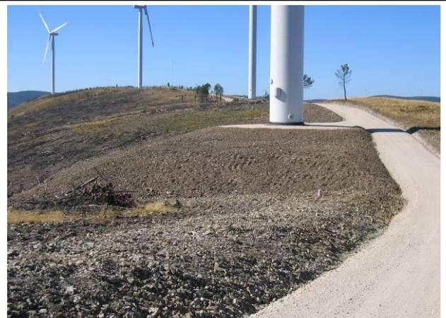
Foto 6 – Aspecto do talude de um plataforma de montagem depois de aplicada uma camada de terra vegetal
