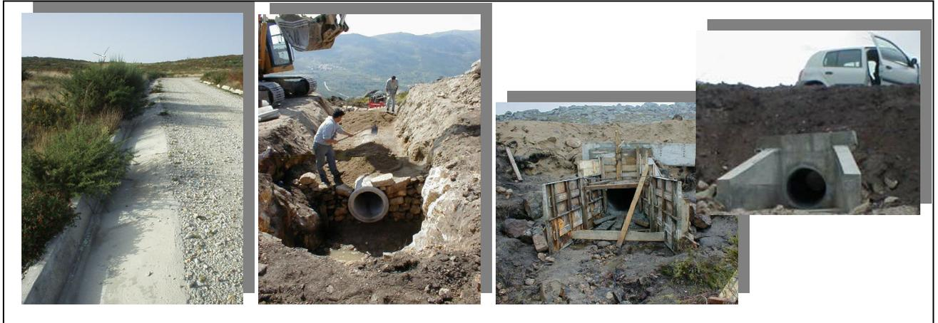
Figura 9 – Valeta e construção de uma passagem hidráulica.
