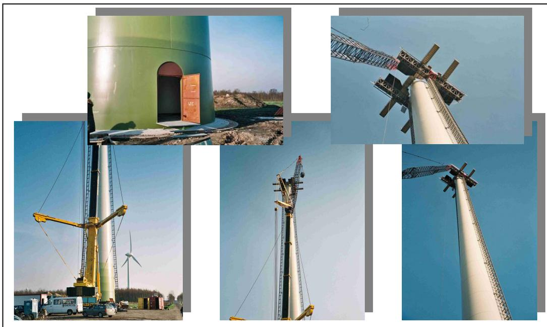
Figura 12 – Montagem de uma torre.
