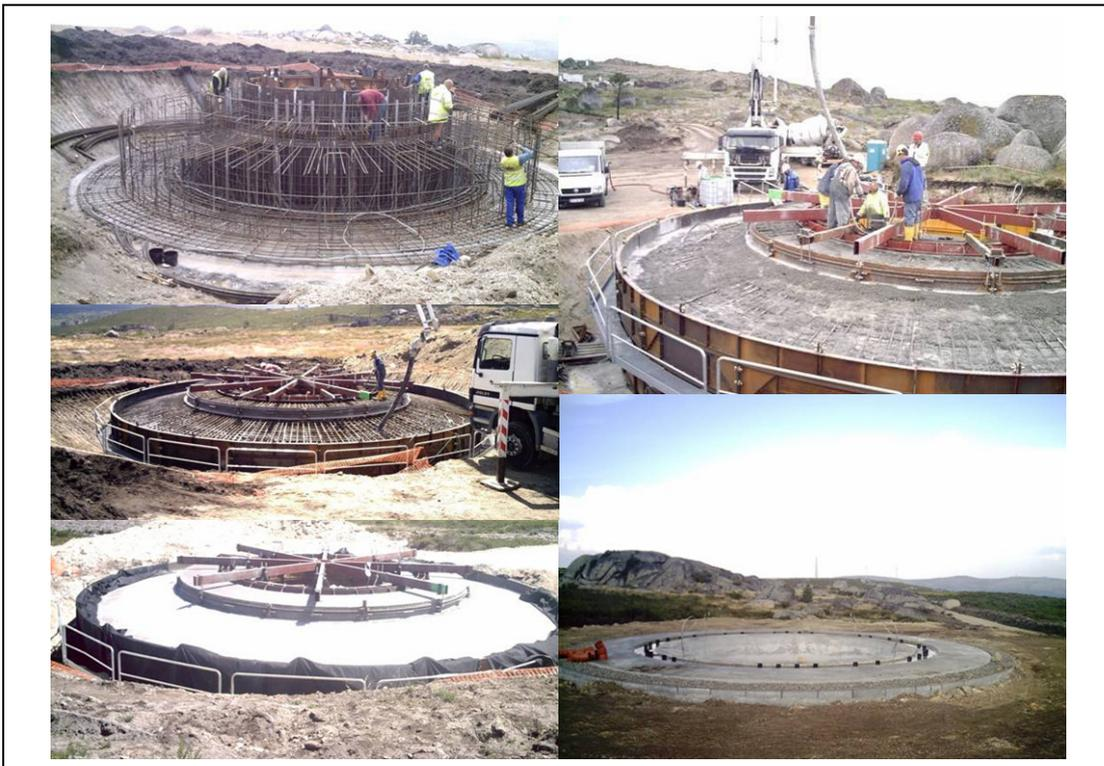
Figura 10 – Execução da fundação da torre de um aerogerador.
