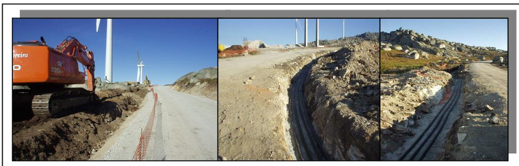
Figura 14 – Vala para instalação dos cabos eléctricos subterrâneos.
