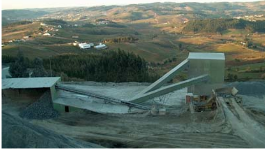
Figura 7: pormenor da unidade de britagem B
