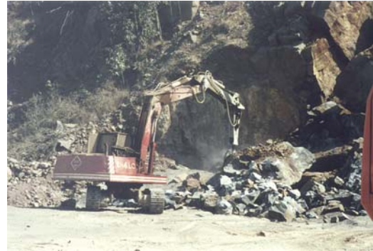
Figura 4: pormenor do desmonte da rocha
