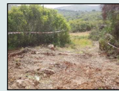
Trabalhos de sinalização dos apoios
