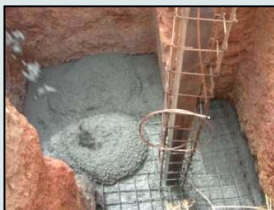
Betonagem do cabouco
