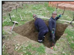
Trabalhos de escavação dos caboucos
