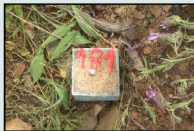
Trabalhos de marcação dos caboucos
