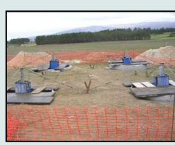
Montagem de um apoio
