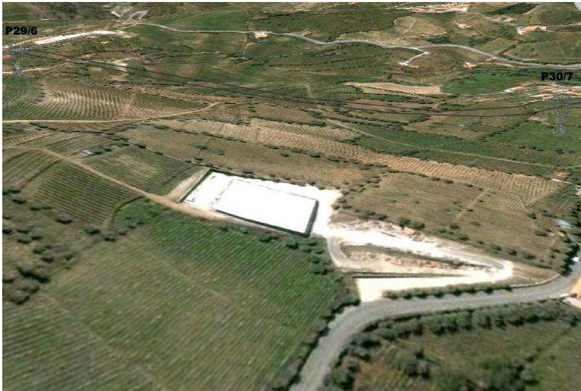
Local de Observação 4 – Vista de Norte ( de um local situado no interior do Alto Douro Vinhateiro) para Sul, na zona entre os apoios P29/6 e P30/7
