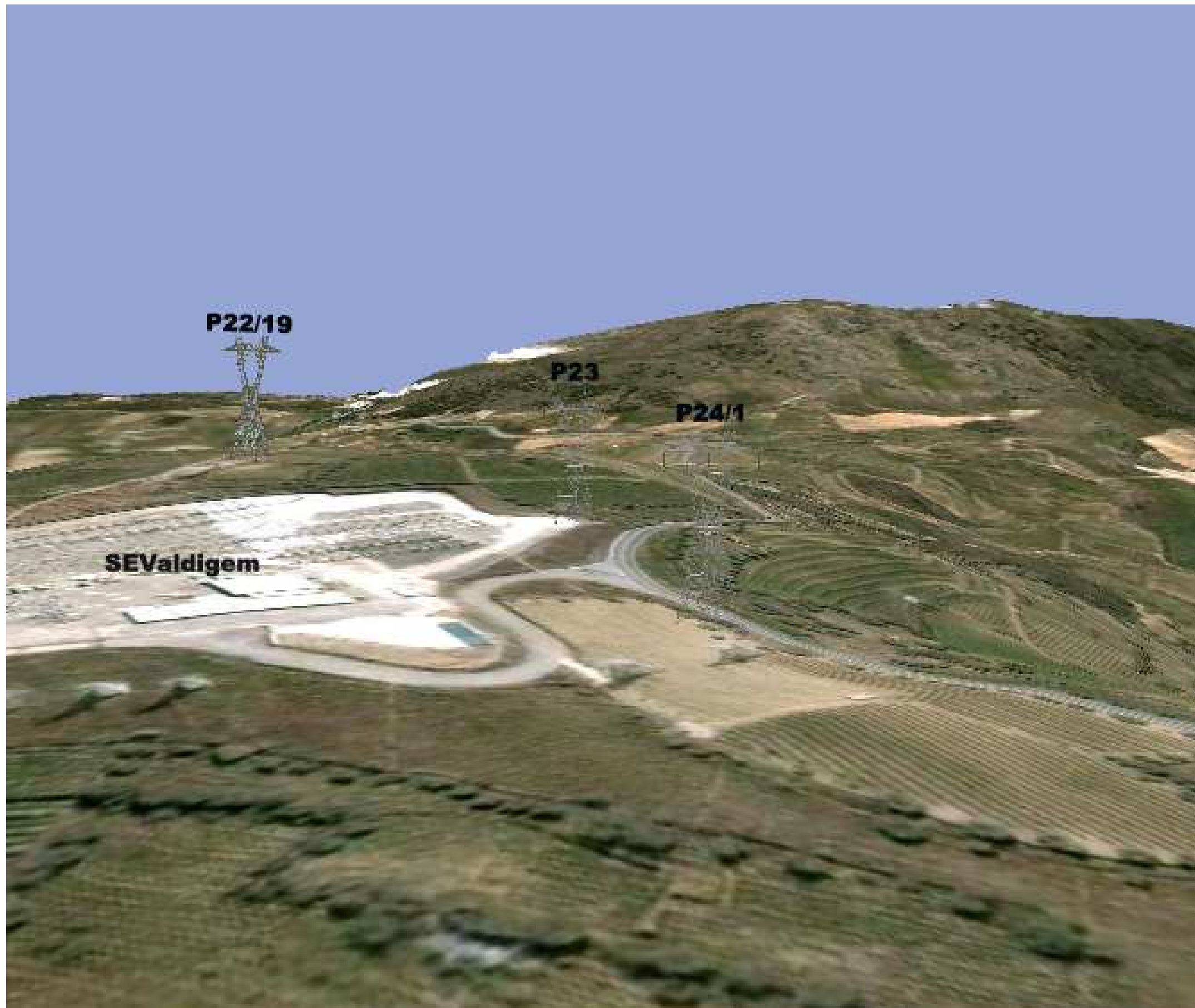
Local de Observação 2 – Vista sobre a zona envolvente à SVG no início do Troço 3 (o apoio P24/1 é o único apoio localizado no interior da área classificada do Alto Douro Vinhateiro (correspondendo à substituição de um apoio da LVG.CL 1 que já se encontra implantado neste local))
