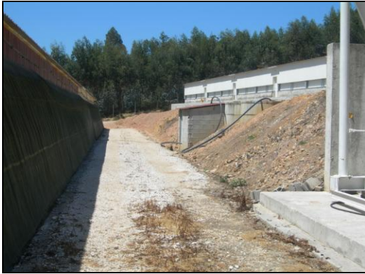
Figura 1- Aproveitamento das terras removidas para terraplanagens
