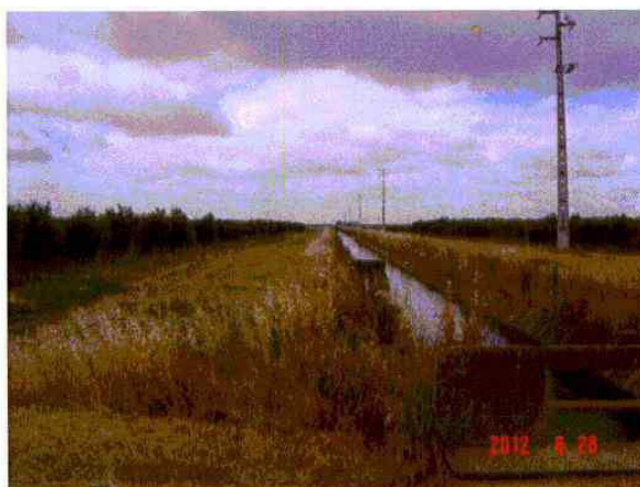
Foto 1 – Início do canal da Barrada
