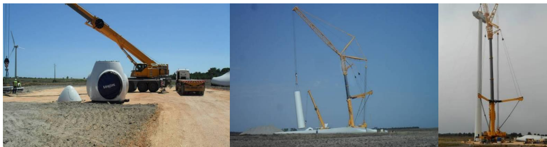
Exemplo da montagem de um aerogerador
