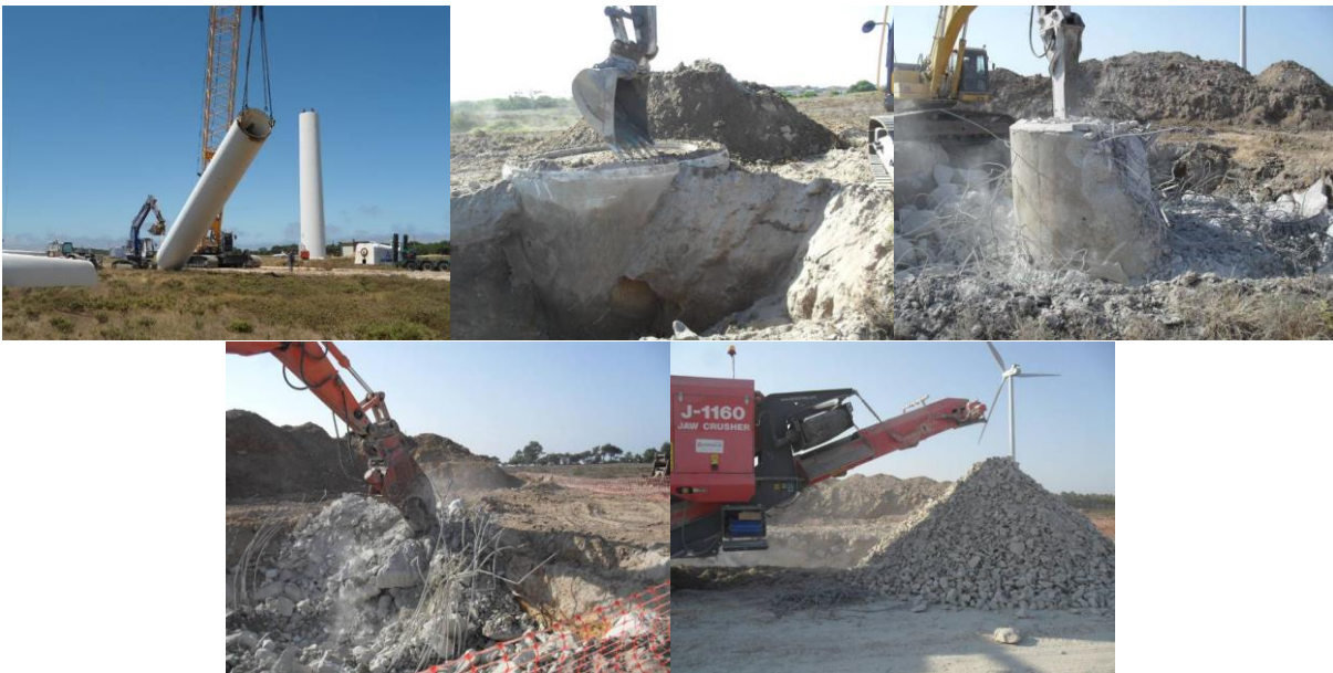
Exemplo do desmantelamento e demolição das fundações de um aerogerador
