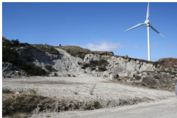
Local de instalação do estaleiro
