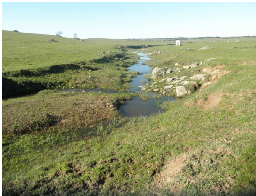
Figura 5. Ribeira do Regedor na zona de construção da barragem.
