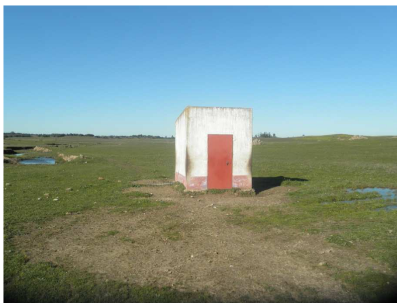
Figura 22. Furo de captação na Herdade do Marnel, o qual ficará, depois da construção da barragem, imediatamente a jusante do aterro.
