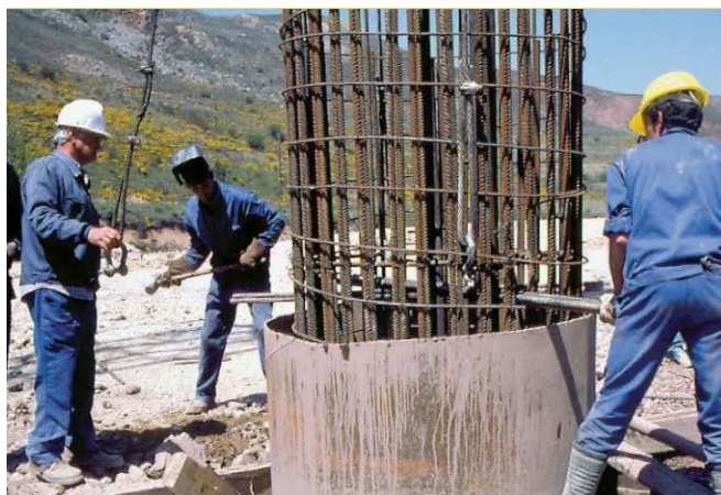
Figura 26 – Introdução da armadura
