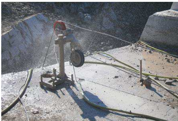
Fotografia 3 – Demolição por corte com fio diamantado
