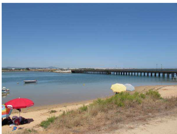
Fotografia 33 – Ponte actual sobre o esteiro do Ancão
