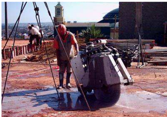
Fotografia 2 – Demolição por corte com serra de disco
