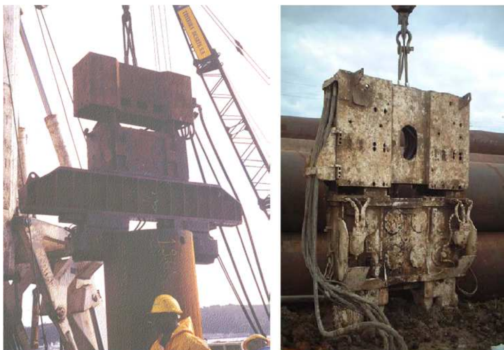
Figura 27 – Cravação do tubo moldador com recurso a martelo vibrador
