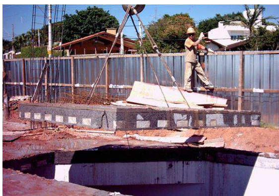
Fotografia 4 – Secções de demolição
