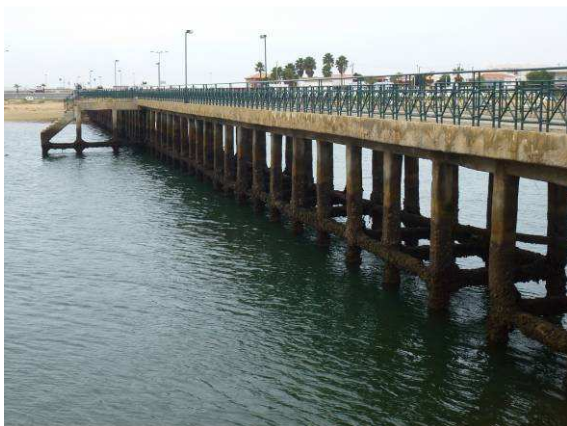
Fotografia 22 – Áreas artificializadas (ponte)
