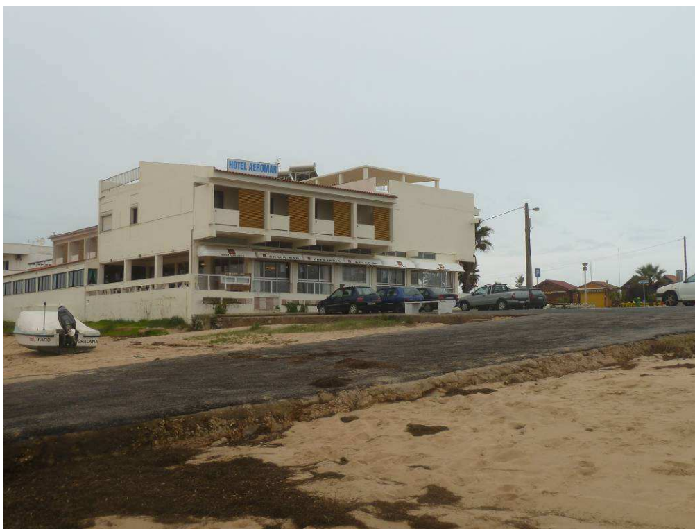
Fotografia 55 – Hotel Aeromar e acesso sul à ponte da Praia de Faro
