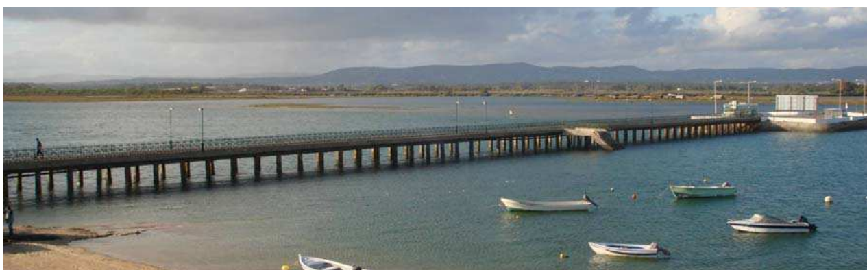
Fotografia 1 – Aspecto geral da ponte existente
