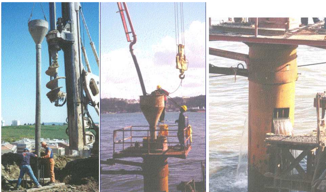
Figura 29 – Betonagem com trémie (esquerda e centro) e expulsão da água dentro do tubo aquando a betonagem (direita)
