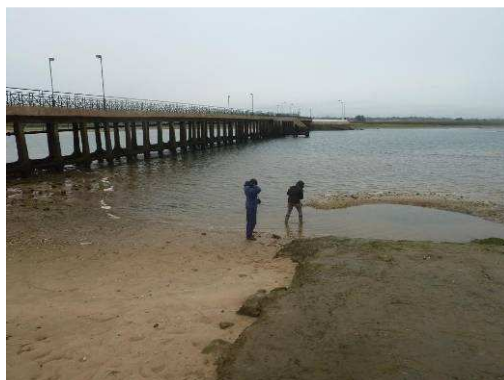
Fotografia 46 – Trabalhos de prospecção na margem da ilha de Faro
