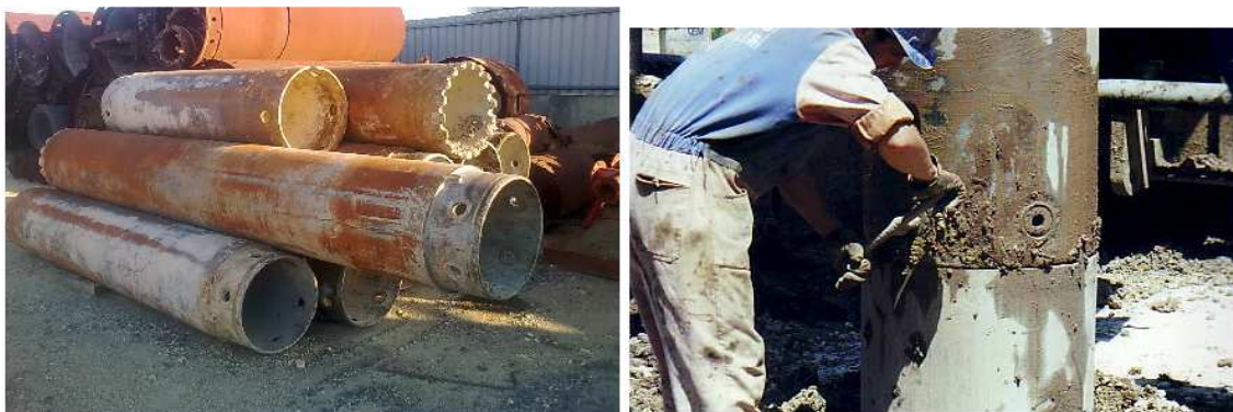
Figura 25 – Troços de tubo moldador (esquerda) e ligação entre troços (direita)
