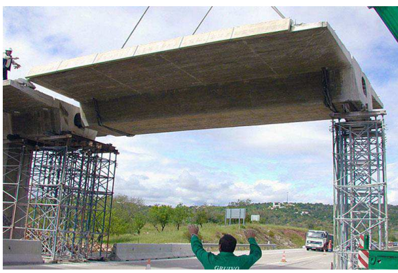
Fotografia 5 – Secções de demolição
