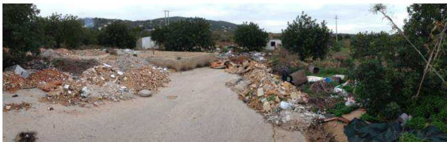
Figura 4 - Exemplo de deposição ilegal de resíduos de construção e demolição
