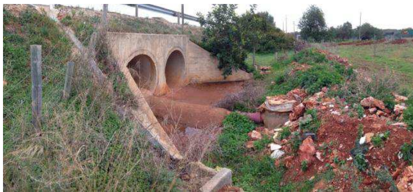
Figura 5 – Saída de uma das passagens hidráulicas existentes para atravessamento da A22
