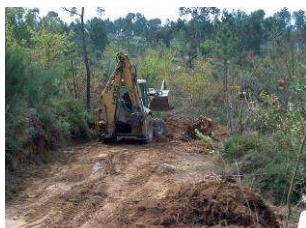
Trabalhos de desmatção
