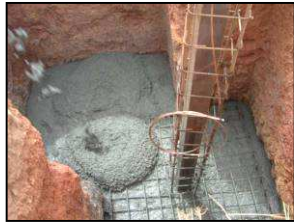
Betonagem do cabouco
