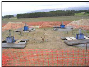
Montagem de um apoio
