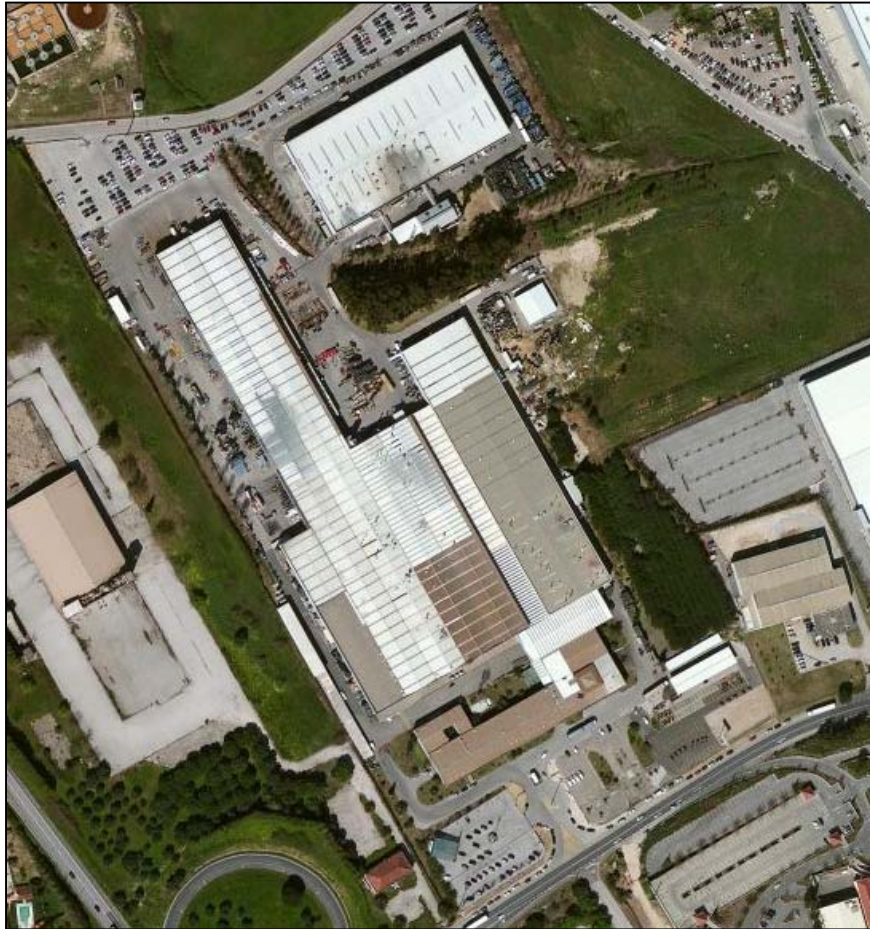
Foto 1 – Vista geral das instalações
