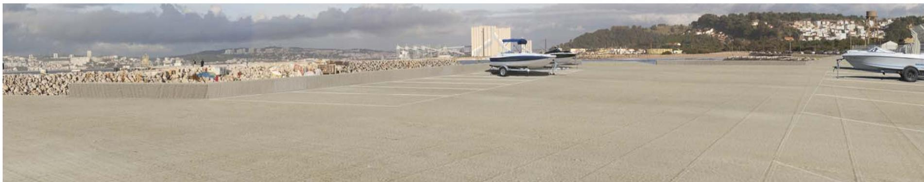
**FIG. 6 – Simulação a partir da Cova do Vapor (vista Poente/Nascente), sendo visível o terrapleno e no seu enfiamento, à direita na figura , a retenção marginal. Do lado esquerdo é visível o molhe de abrigo e à direita a forma como as embarcações poderão ficar estacionadas, bem como ainda a rede que vedará o terrapleno**
