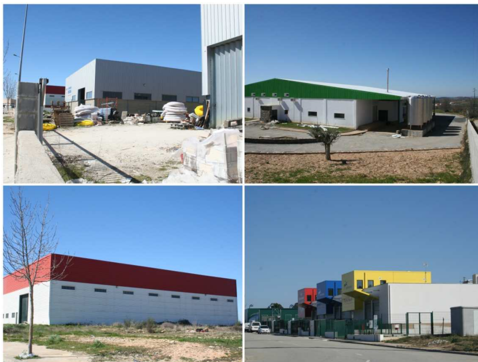
Foto 37, 38, 39, 40 - Aspeto geral dos edifícios
