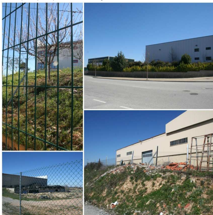
Foto 41, 42, 43, 44 - Vedações/Muros na Zona Industrial
