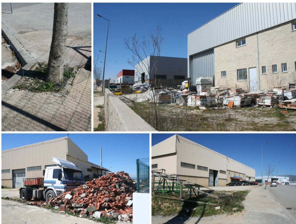
Foto 45, 46, 47, 48 – Espaço Público e Interior dos Lotes
