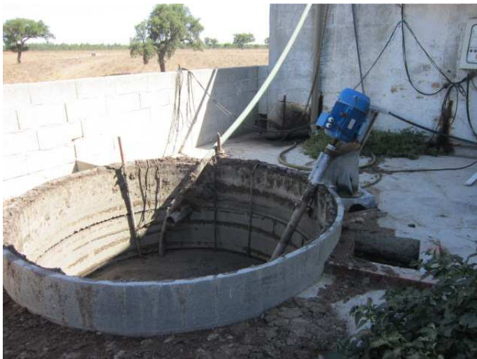
Fotografia 1: Poço de recepção.
