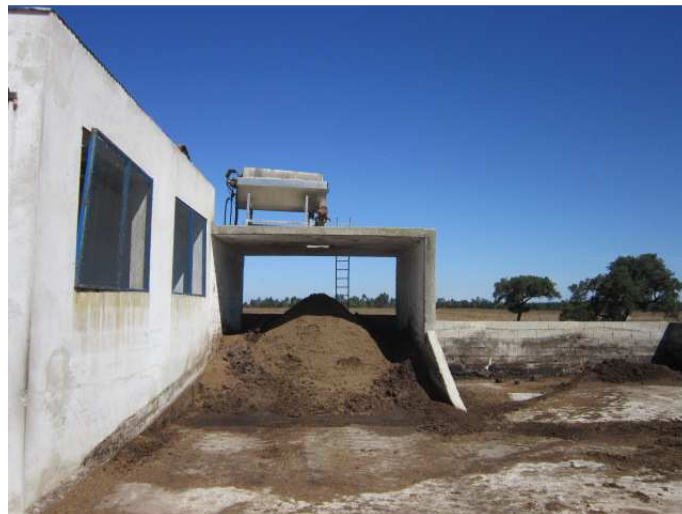
Fotografia 2: Sseparador de solidos.
