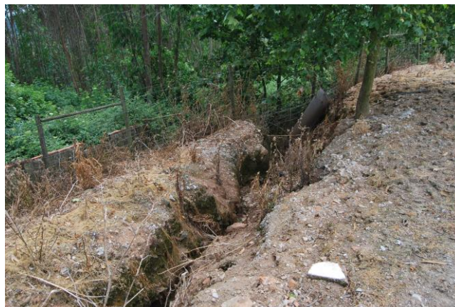
Figura 5.10 – Linha de água no extremo Sul do terreno das instalações
