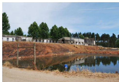
Figura 6.3 – Segunda lagoa de tratamento / armazenamento de efluentes pecuários da instalação
