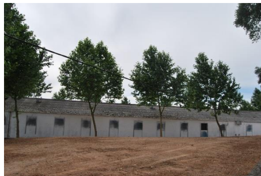
Figura 6.7 – Vista sobre cortina arbórea ao redor das edificações
