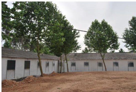
Figura 4.4 – Aspeto exterior dos pavilhões de criação de suínos
