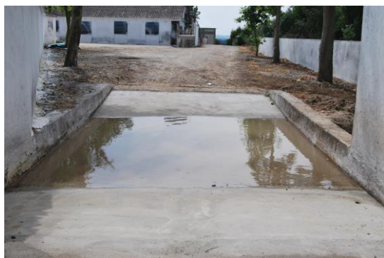
Figura 4.1 – Entrada na instalação com rodilúvio
