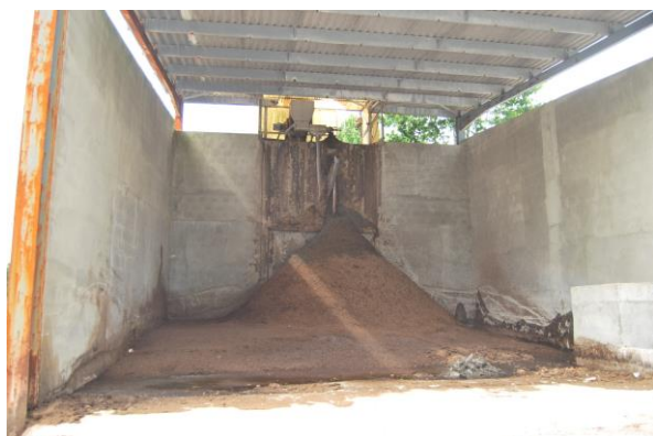
Figura 4.3 – Edifício de armazenamento de estrume
