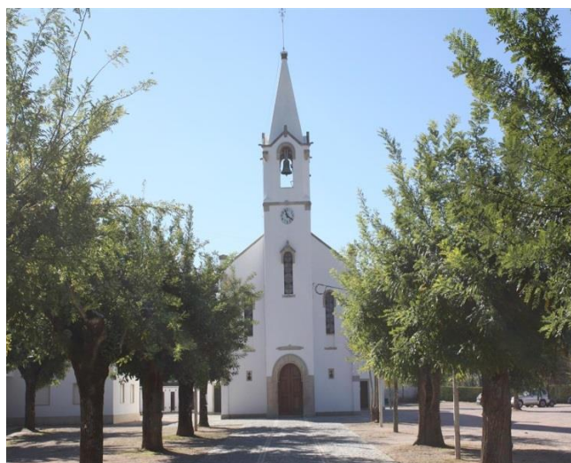
Figura 5.47 – Igreja Paroquial de Águas Belas
