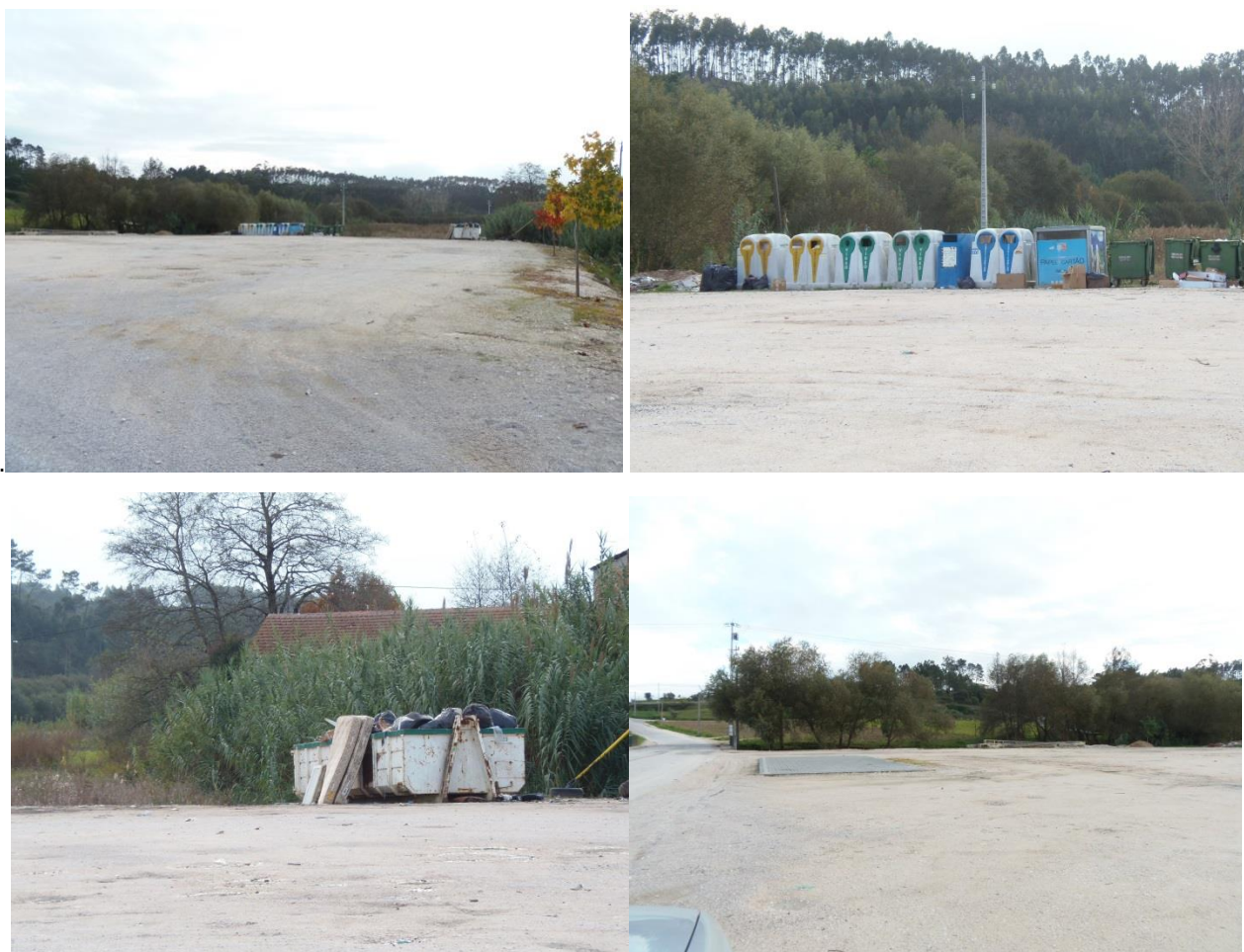
Figura 21 - Vista geral dos locais previstos para implantação do estaleiro (Estaleiro 1).
