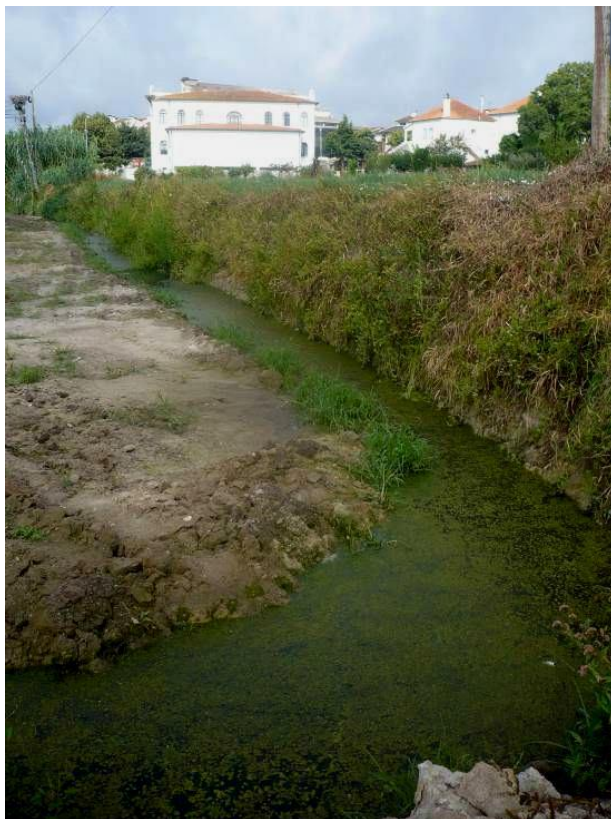
Figura 5 - Aspeto da vala existente na zona inicial do traçado (lado direito), com depósitos de terraço (do lado mais alto) e aluvionares (na base)
