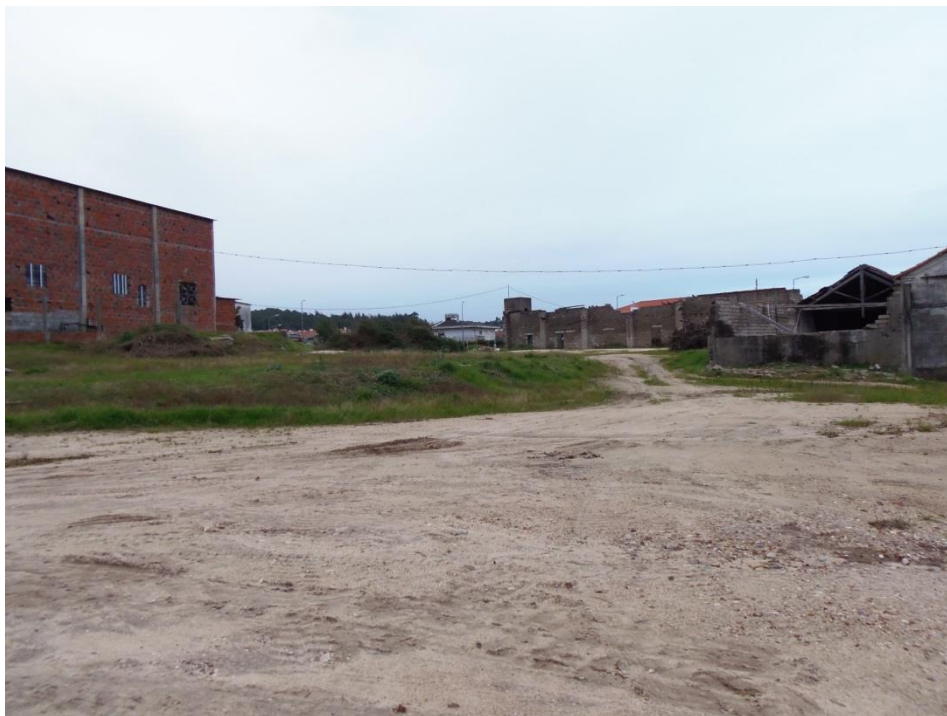
Figura 22 - Vista geral do local previsto para implantação do estaleiro (Estaleiro 2).
