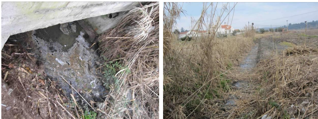
Figura 15 – Pontão existente e linha de água a jusante.
