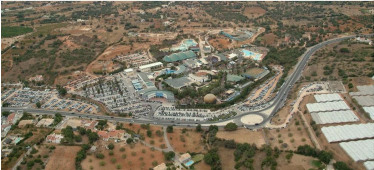
Figura 82 – Fotografia aérea onde é perceptível o atual equipamento e as novas áreas de expansão.
