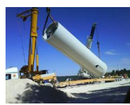
Montagem da torre do aerogerador
