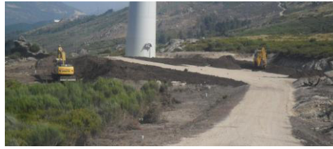
Trabalhos de requalificação da plataforma de montagem de um aerogerador
