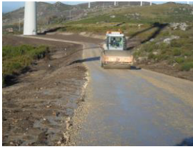
Trabalhos de compactação do acesso após requalificação dos taludes
