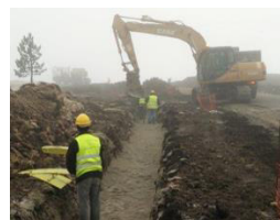
Execução da base em areia
