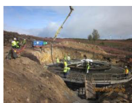
Execução da armadura da fundação do aerogerador
