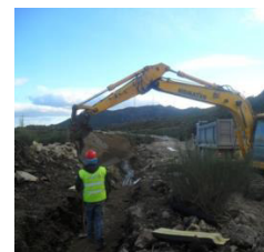
Fecho da vala
