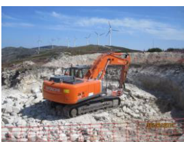
Abertura do cabouco para a fundação do aerogerador
