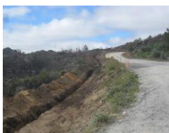
Abertura da vala
