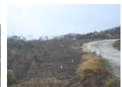
Aspeto final da vala de cabos
