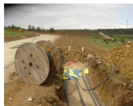
Colocação dos cabos
