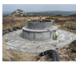
Betonagem da fundação do aerogerador
