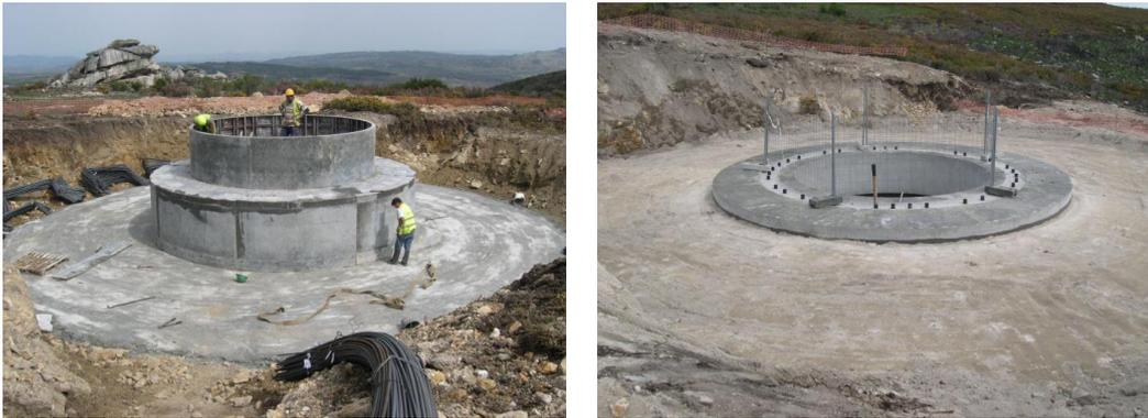
Fotografias 4.11 e 4.12 – Exemplo de execução da fundação da torre de um aerogerador (continuação)
