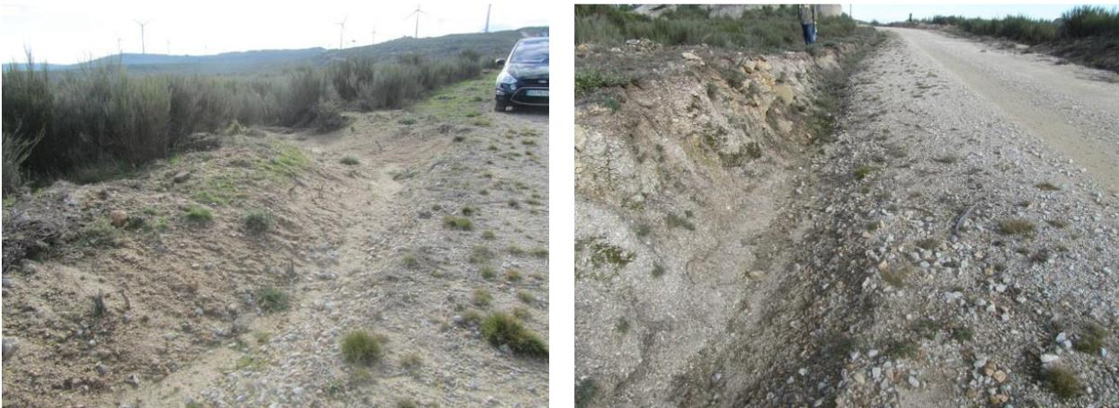
Fotografias 4.3 e 4.4 – Exemplo de valetas sem revestimento, observando-se à esquerda como é efetuado o encaminhamento do escoamento para a linha de água mais próxima
