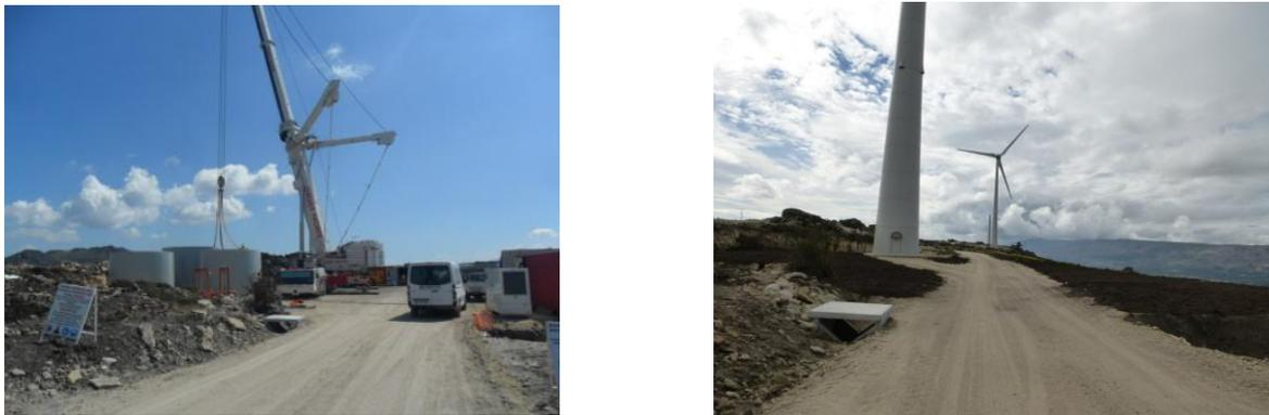
Fotografias 4.13 e 4.14 – Plataforma de trabalho adjacente a um aerogerador, à esquerda durante a fase de montagem e à direita após a recuperação paisagística
