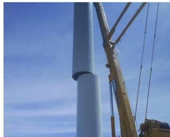
Fotografias 4.18 a 4.22 – Montagem da torre de um aerogerador
