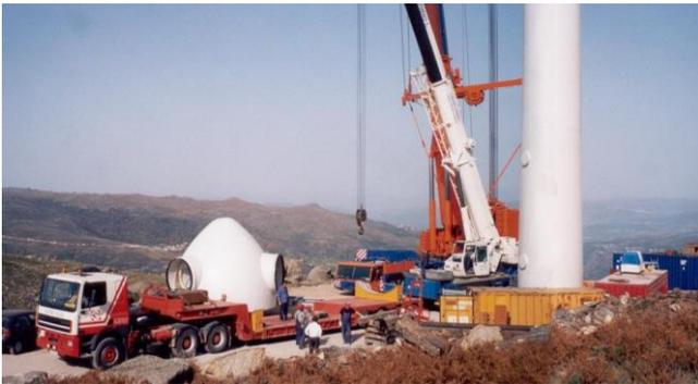
Fotografias 4.15 a 4.17 – Ocupação de uma plataforma para montagem de um aerogerador
