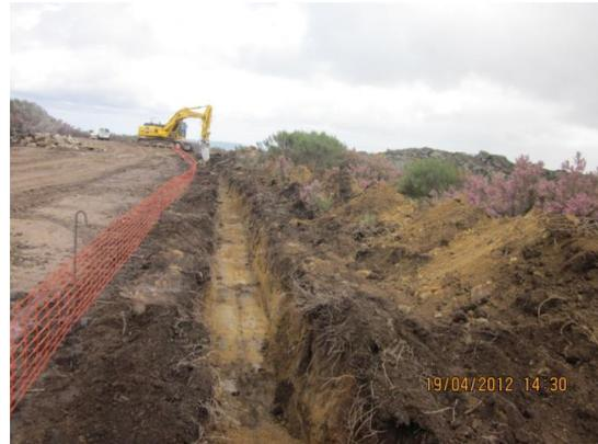
Fotografias 4.5 e 4.6 – Exemplo de vala para instalação de cabos elétricos
