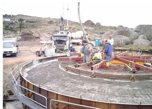
Fotografias 4.7 a 4.10 – Exemplo de execução da fundação da torre de um aerogerador
