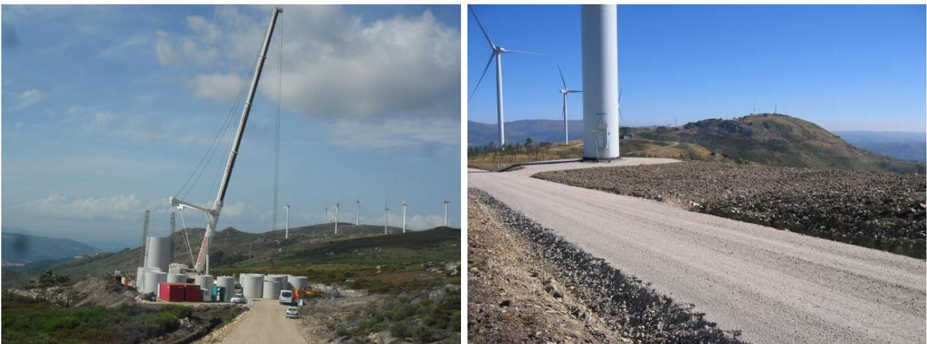
Fotografias 4.1 e 4.2 – Plataforma de trabalho adjacente a um aerogerador, à esquerda durante a fase de montagem e à direita após a recuperação paisagística.
