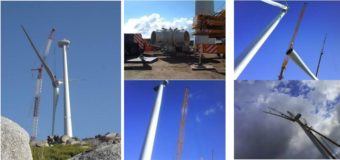
Fotografias 4.23 a 4.27 – Montagem das pás de um aerogerador
