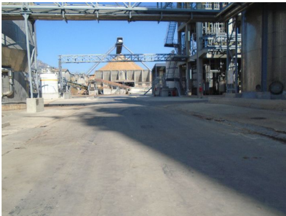
Figura Pa15 - Visibilidade do Solo – Solo Urbano – acesso à área reservada para a Receção e novo Silo de Biomassa
