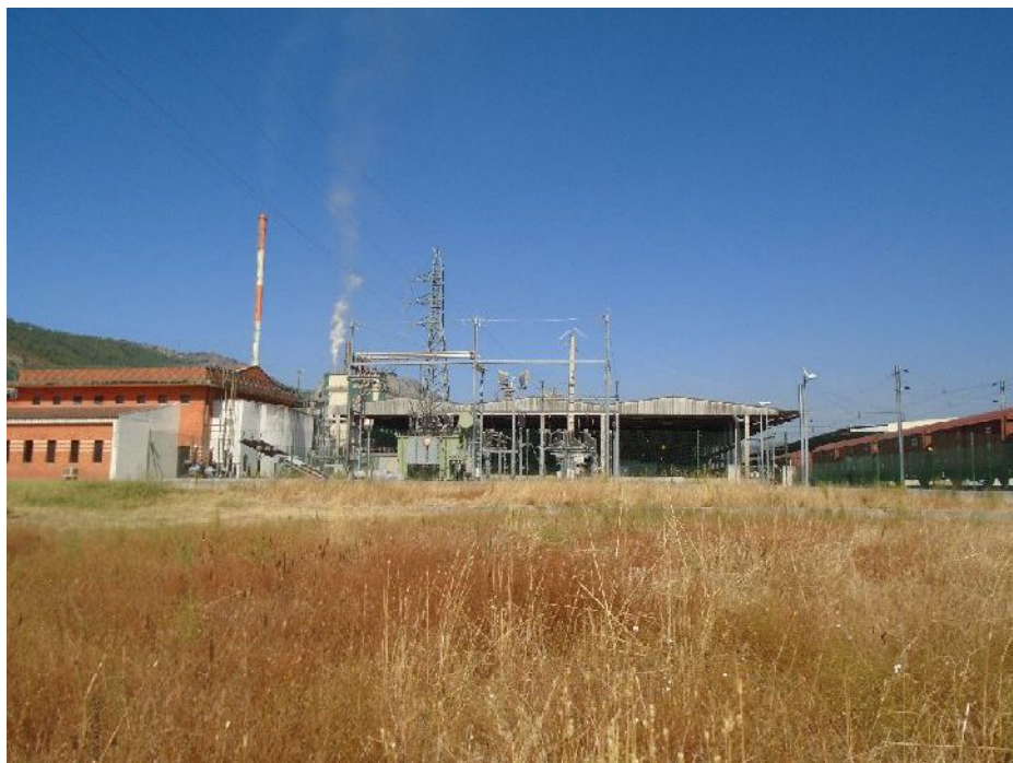
Figura Pa11 - Visibilidade do Solo – Visibilidade Mista – Área reservada a ampliação da Subestação.
