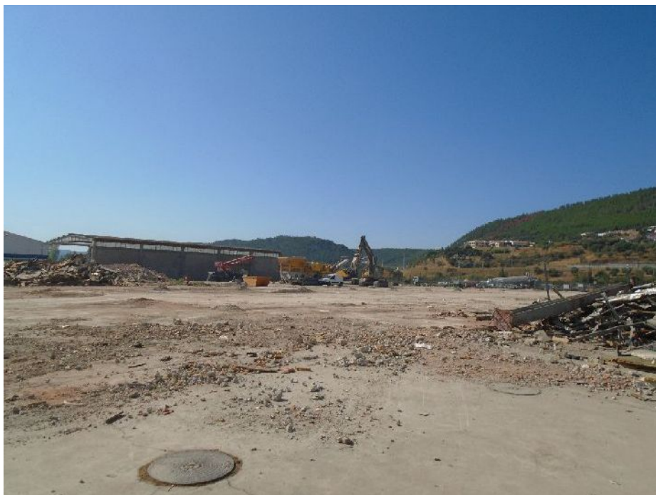
Figura Pa13 - Visibilidade do Solo – Solo Urbano - Área reservada à Nova Central de Biomassa e Silo diário.
