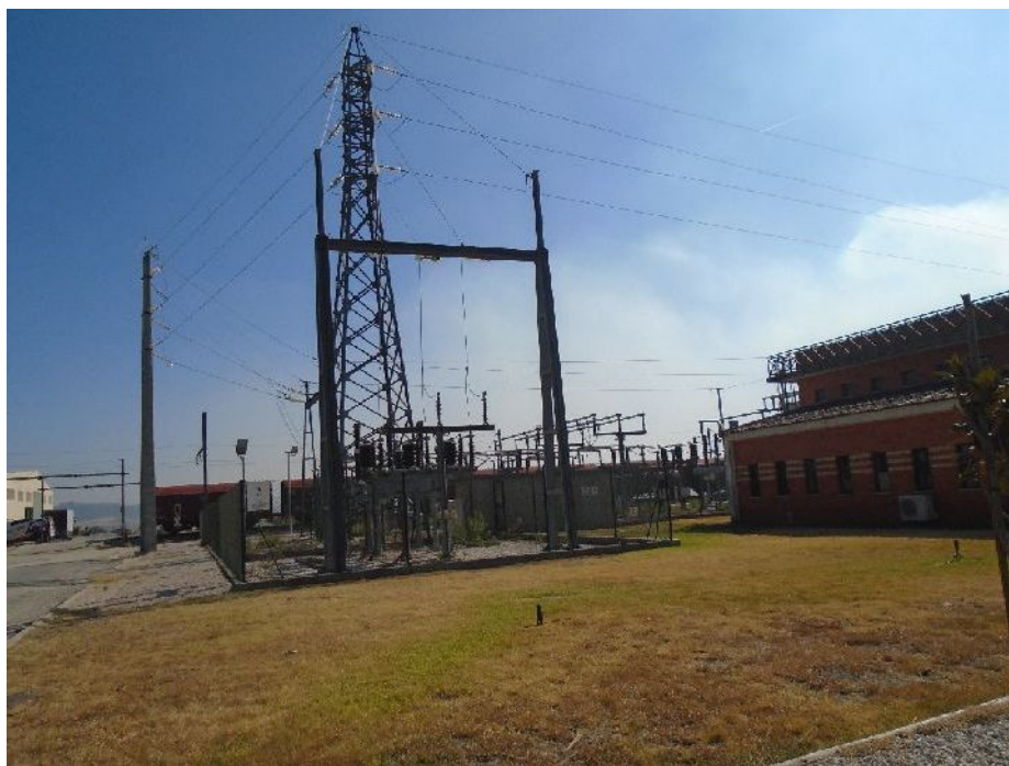
Figura Pa07 - Visibilidade do Solo – Solo Urbano – Área reservada a ampliação da Subestação.
