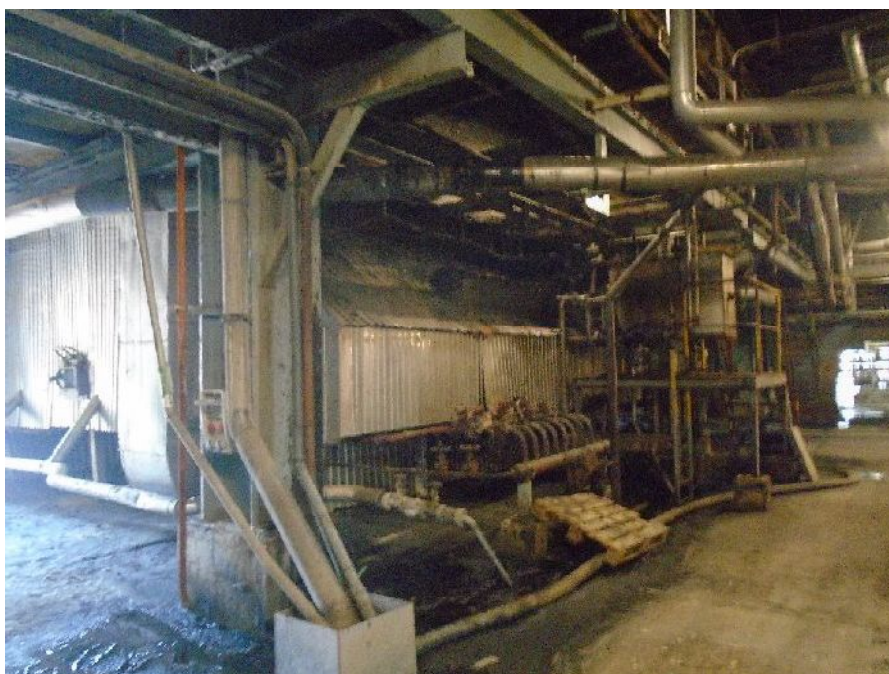
Figura Pa14 - Visibilidade do Solo – Solo Urbano – interior da área reservada à Nova Central de Biomassa.
