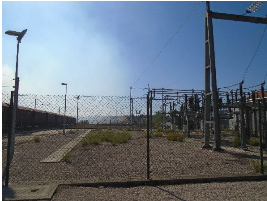
Figura Pa08 - Visibilidade do Solo – Solo Urbano – Área reservada a ampliação da Subestação.
