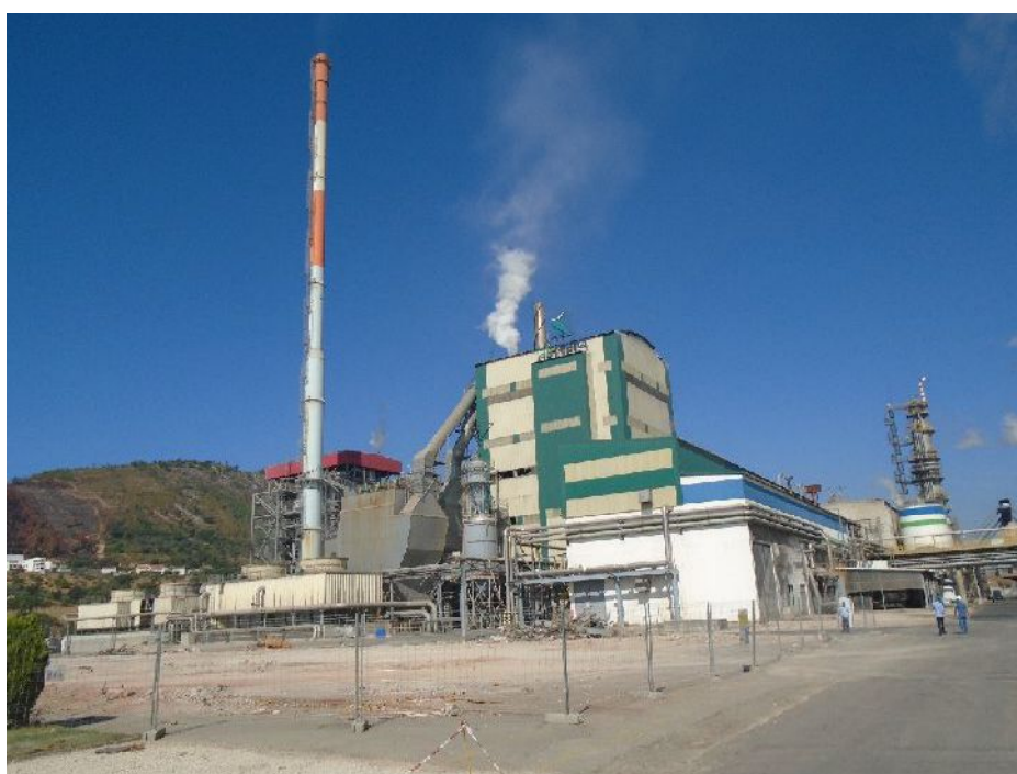
Figura Pa12 - Visibilidade do Solo – Solo Urbano - Área reservada à Nova Central de Biomassa e Silo diário.
