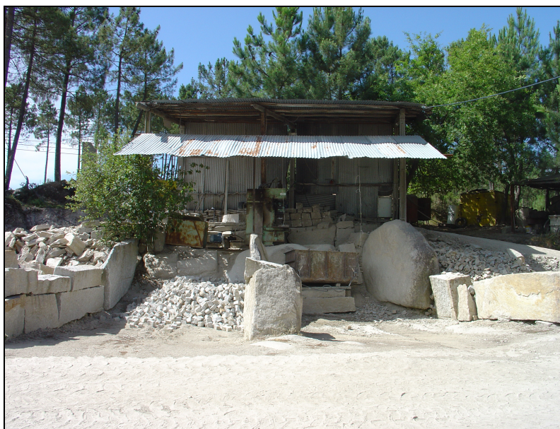
Figura 3.2. Fabricação de calçada.
