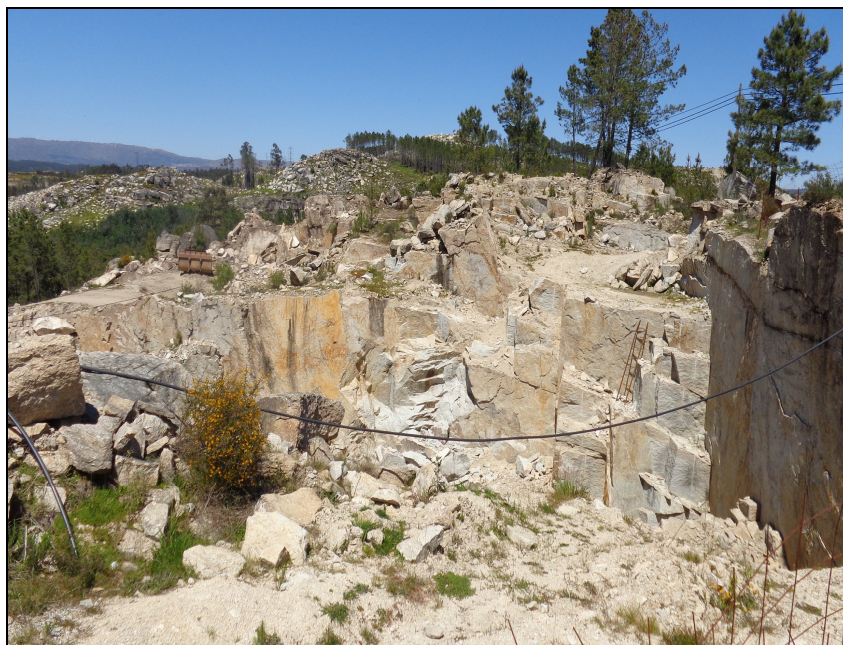
Figura 5.2. Desmonte do maciço.
