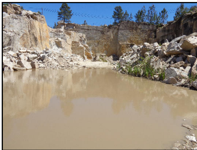
Figura 4.44. Acumulação de água no interior da pedreira.
